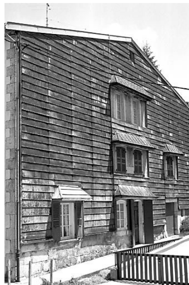
Façade droite. Phot. Jérôme Mongreville IVR43_20003900180X
