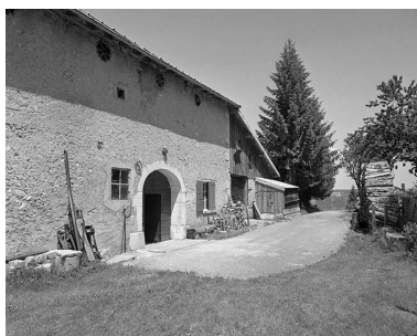
Façade postérieure, entrée de grange. Phot. Jérôme Mongreville IVR43_20003900221X
