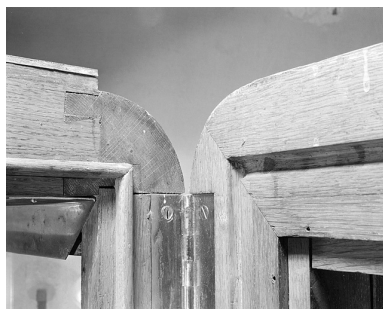
Détail d'assemblage et du joint d'étanchéité entre la porte et le bâti. Phot. Jérôme Mongreville IVR43_20032501041X
