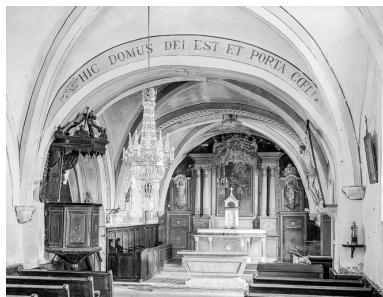
Vue du chœur depuis la nef. Phot. Yves Sancey IVR43_19753900288V
