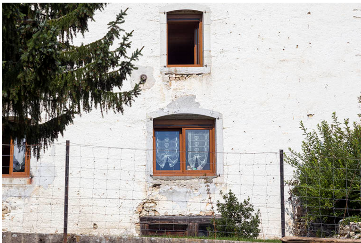
Façade est : fenêtres.
