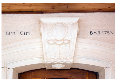
Façade sud : arc monolithe en béton avec sa fausse clef de voûte, des initiales et un chronogramme. Phot. Yves Sancey IVR43_20132501328NUC2A
