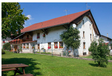
Façade sud, de trois quarts droite. Phot. Yves Sancey IVR43_20132501342NUC2A
