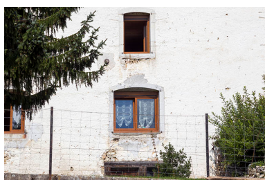
Façade est : fenêtres. Phot. Yves Sancey IVR43_20132501339NUC2A
