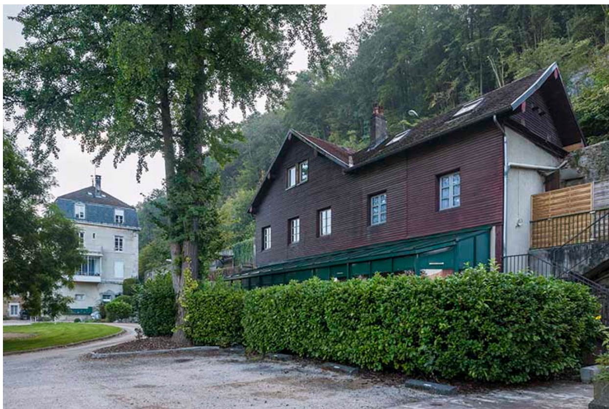
Logement patronal et logement (remanié).
