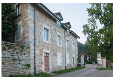
La conciergerie et l'entrée du site. Phot. Jérôme Mongreville IVR43_20142501591NUC4A
