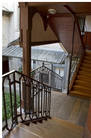
Escalier à cage ouverte : vue depuis l'intérieur. Phot. Yves Sancey IVR43_20112502796NUC2A
