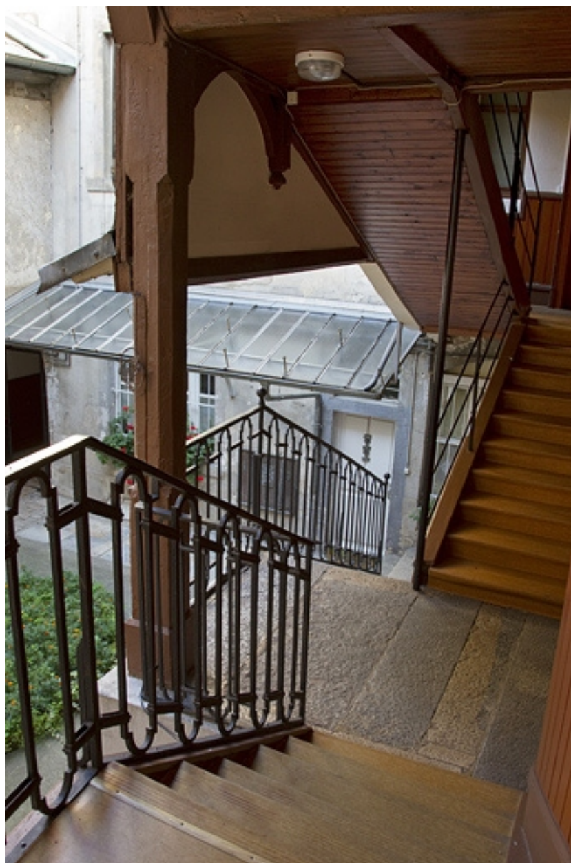
Escalier à cage ouverte : vue depuis l'intérieur.
