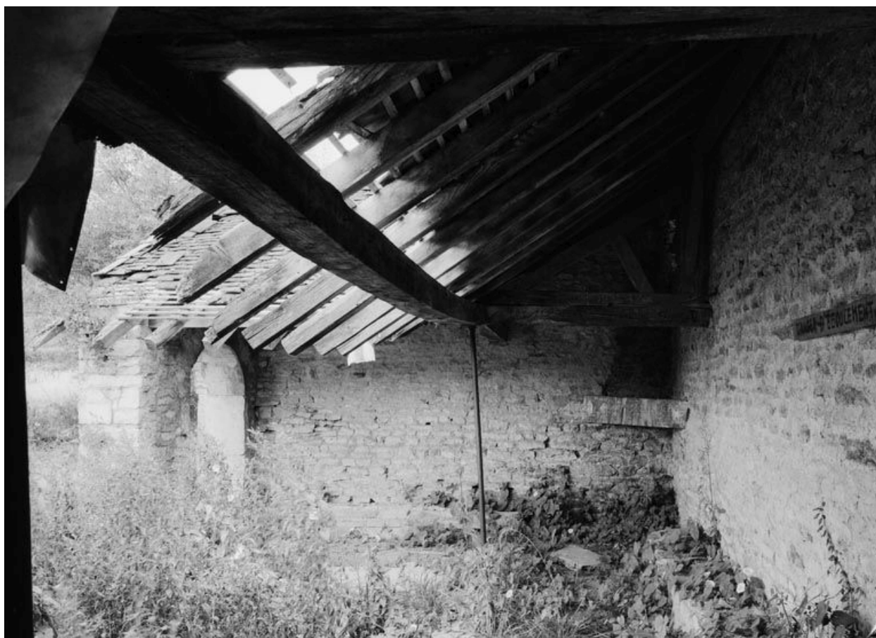
Vue de l'intérieur du lavoir.
