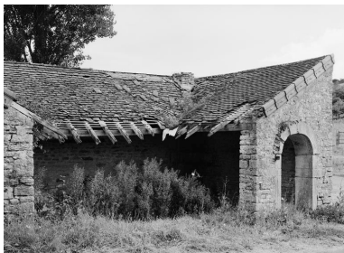
Vue d'ensemble du lavoir, de plan en U. Phot. Jean-Luc Duthu IVR26_19792101175V
