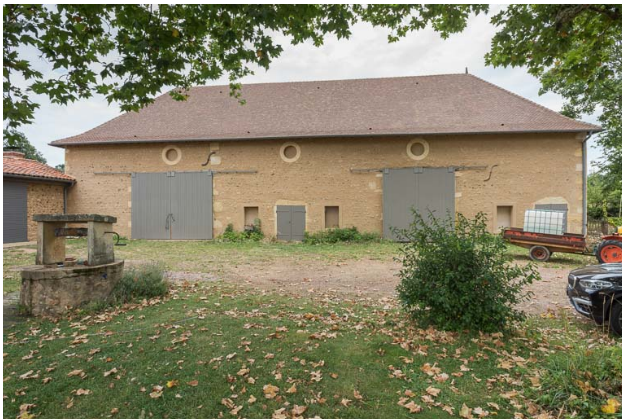
Façade antérieure de la grange
