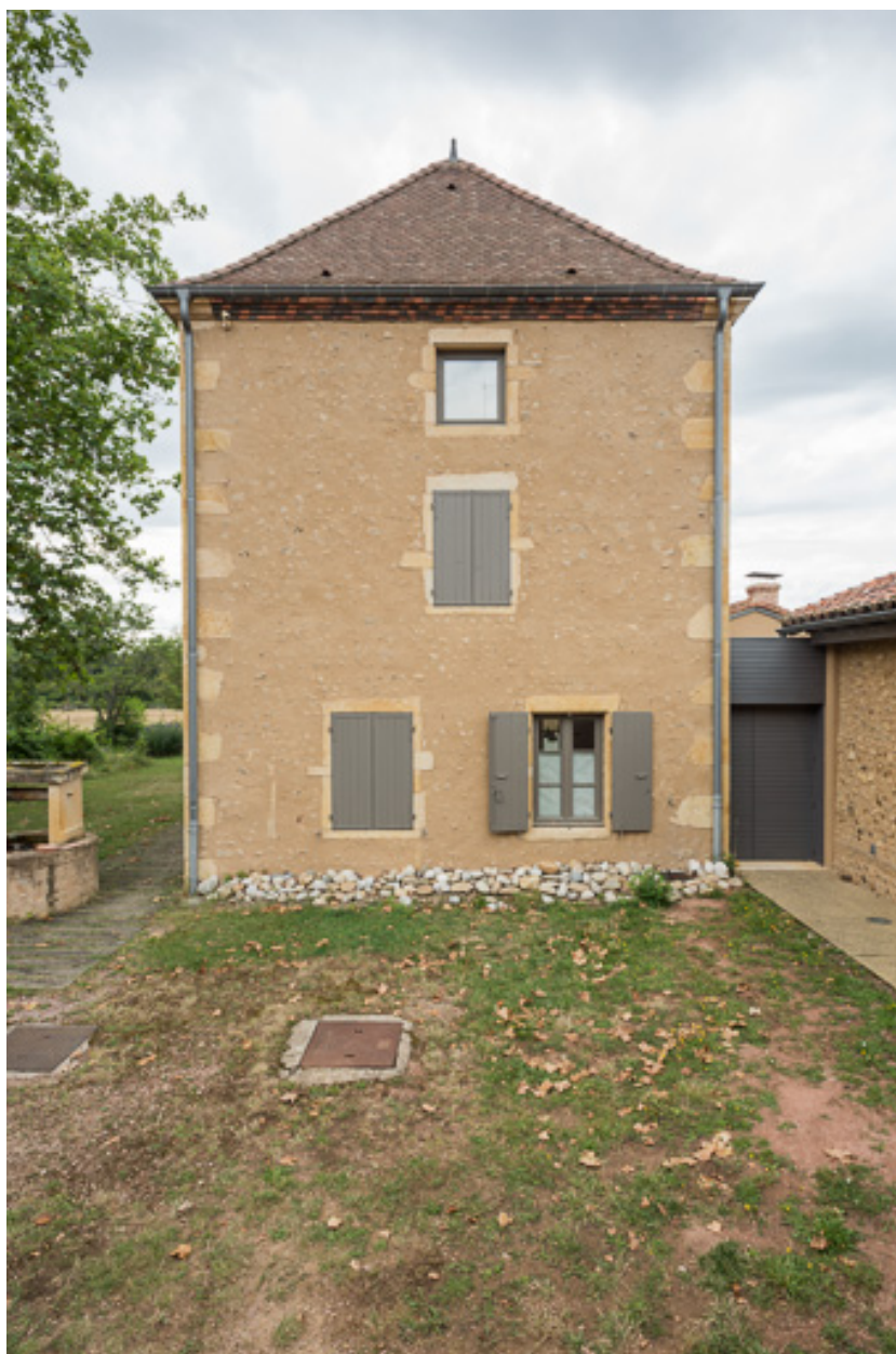
Façade latérale est de la maison
