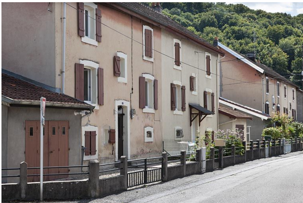
Façades antérieures vues de trois quarts.
