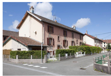
Vue d'ensemble d'une rue. Phot. Jérôme Mongreville IVR43_20112502194NUC4A
