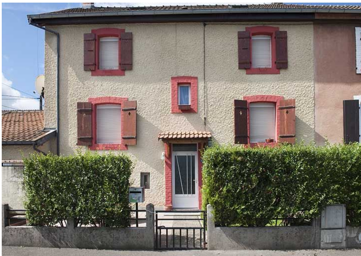
Détail d'une façade antérieure.
