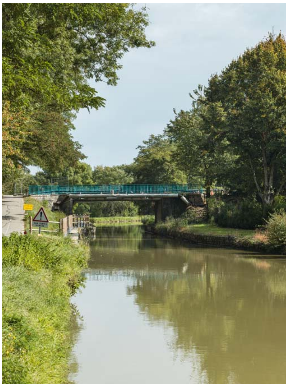
Vue d'ensemble du pont.
