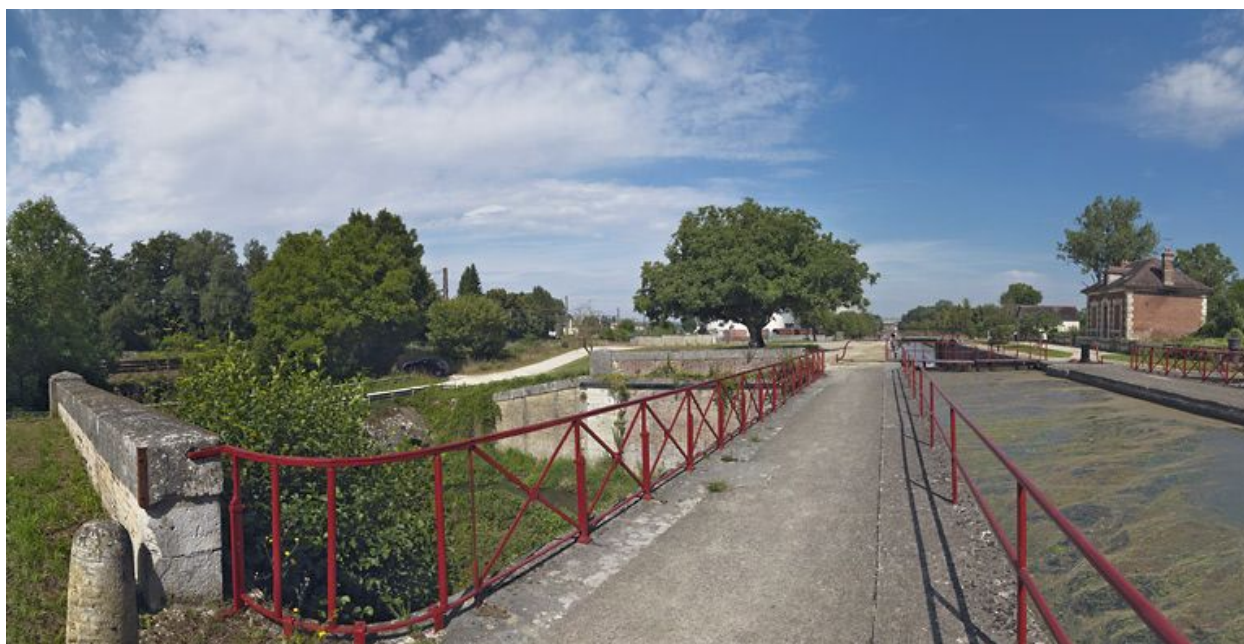
Pont-canal vu du dessus.
