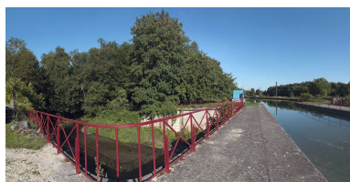
Sur le pont canal. Phot. Thierry Kuntz IVR26_20118900118NUC4AQ
