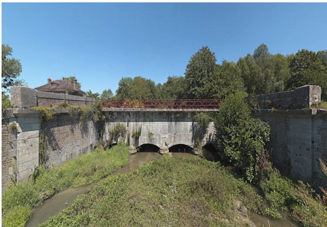
Arches du pont-canal vues de face.
