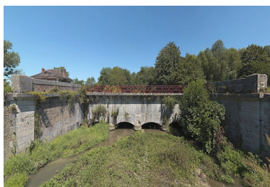
Arches du pont-canal vues de face. Phot. Thierry Kuntz IVR26_20118900128NUC4A
