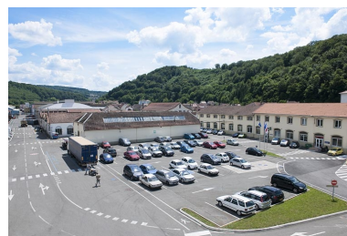
Vue plongeante du site depuis le nord. Phot. Jérôme Mongreville IVR43_20112501330NUC4A
