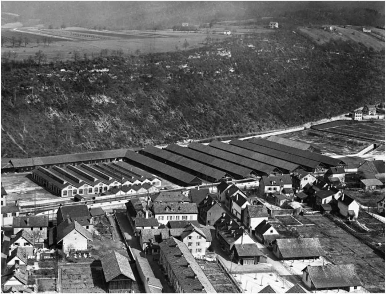
Extrémité sud de l'usine. Photogr., s.n., s.d. [vers 1900].
