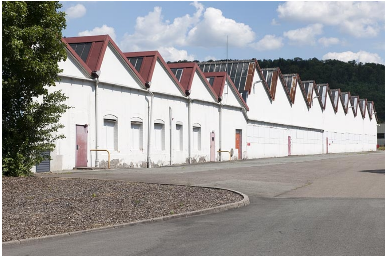
Pignons des entrepôts industriels sud.
