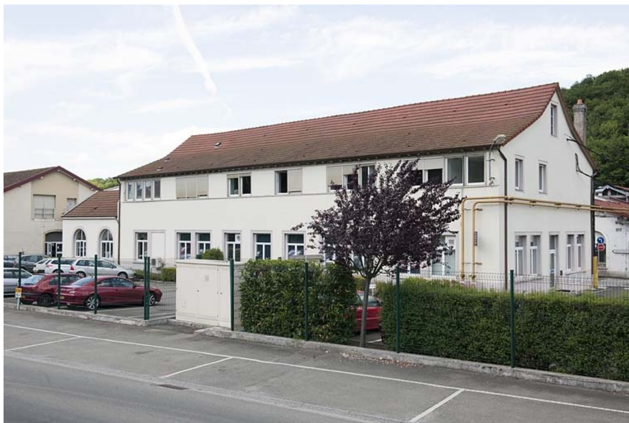
Façade ouest du bureau d'études.
