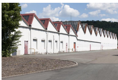
Pignons des entrepôts industriels sud.
