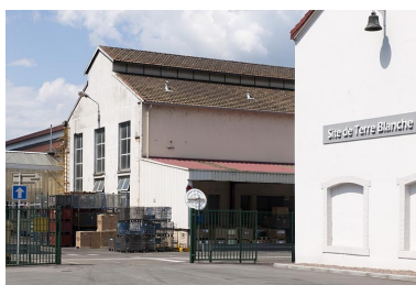
Magasin industriel vu de trois quarts. Phot. Jérôme Mongreville IVR43_20112501361NUC4A
