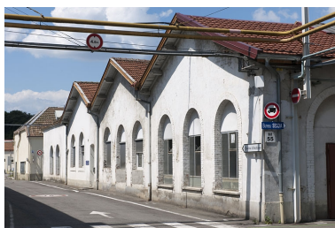
Pignons ouest de l'atelier de maintenance. Phot. Jérôme Mongreville IVR43_20112501349NUC4A
