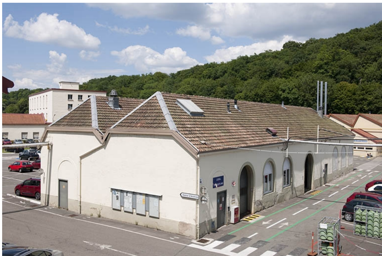
Magasin industriel depuis le sud-ouest.
