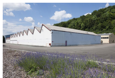
Entrepôts industriels depuis le sud.
