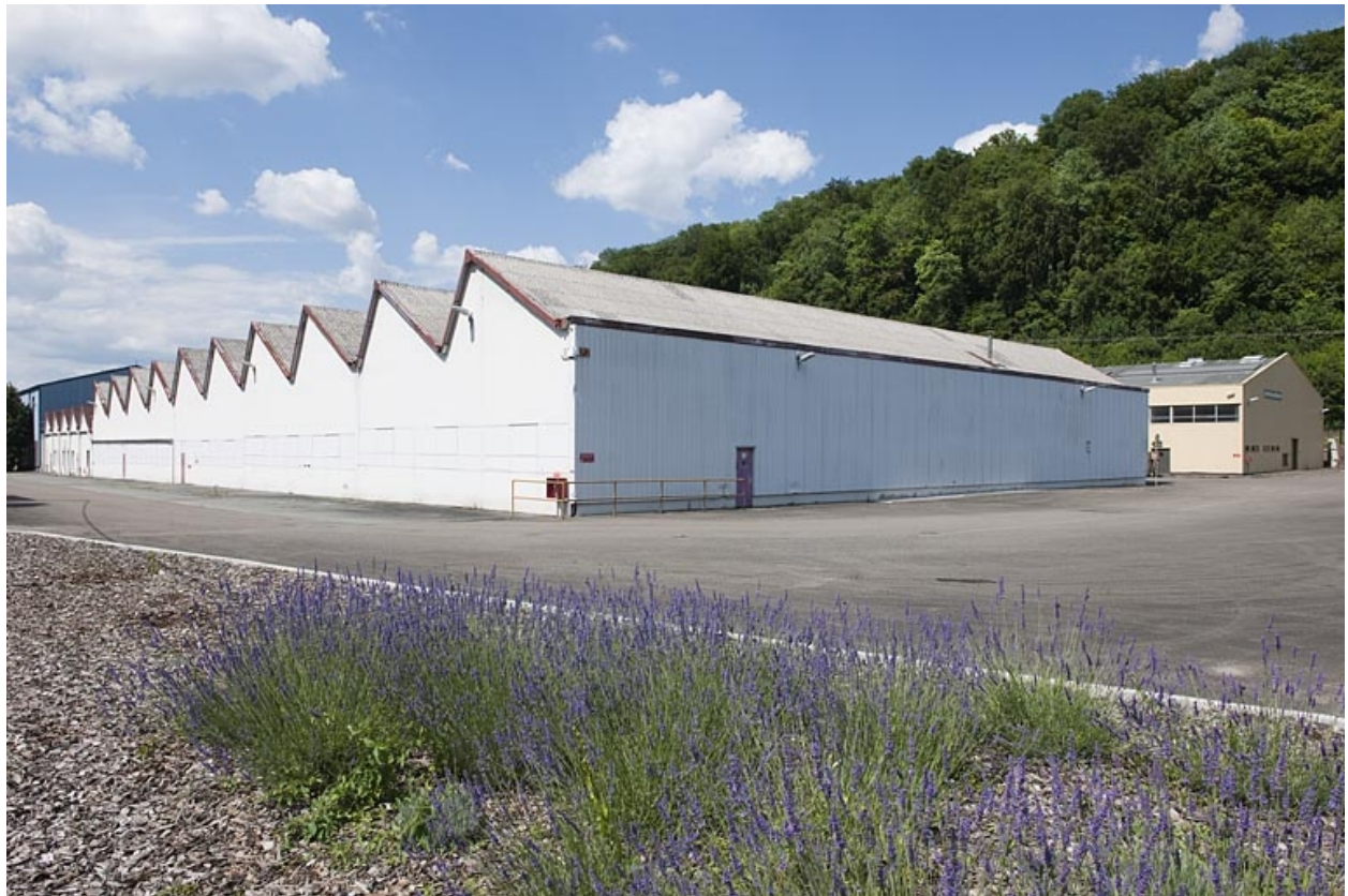
Entrepôts industriels depuis le sud.
