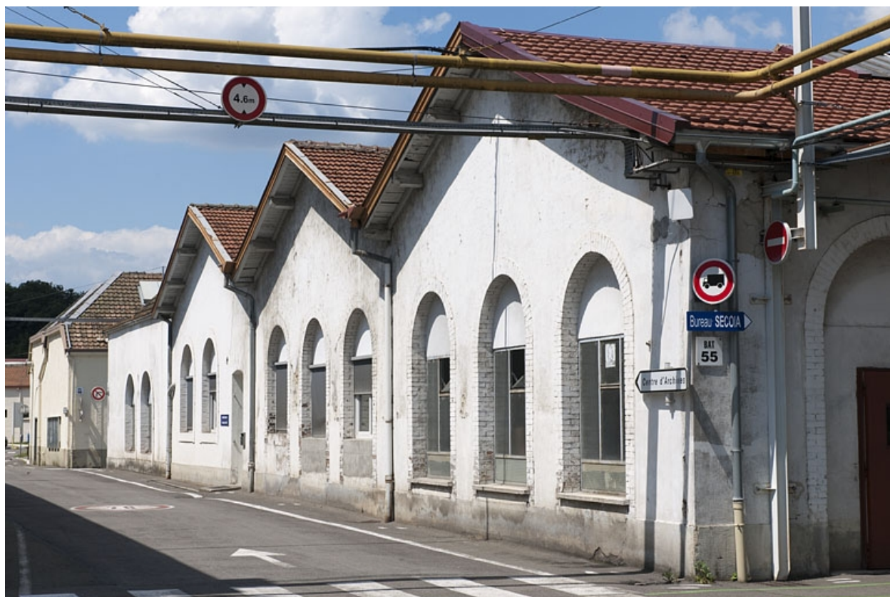
Pignons ouest de l'atelier de maintenance.
