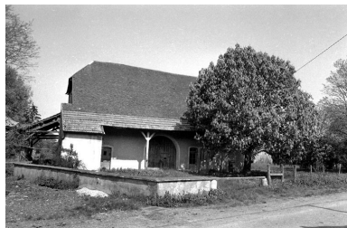
Vue d'ensemble depuis la rue. Phot. Bernard Lardière IVR43_19817000351Z
