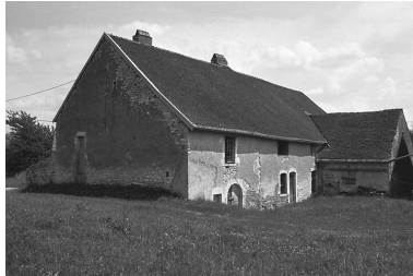
Façade postérieure. Phot. Bernard Lardière IVR43_19817000222Z
