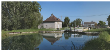
Vue d'amont. Phot. Thierry Kuntz IVR26_20112103133NUC4A
