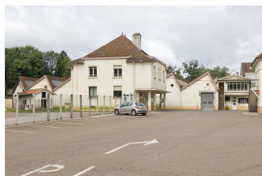
La conciergerie. Phot. Jérôme Mongreville IVR43_20097000702NUC2A
