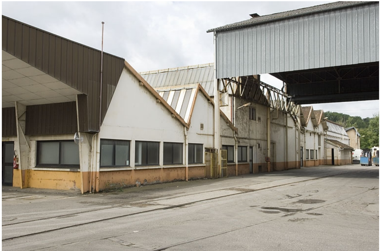
Façades nord des ateliers de fabrication.
