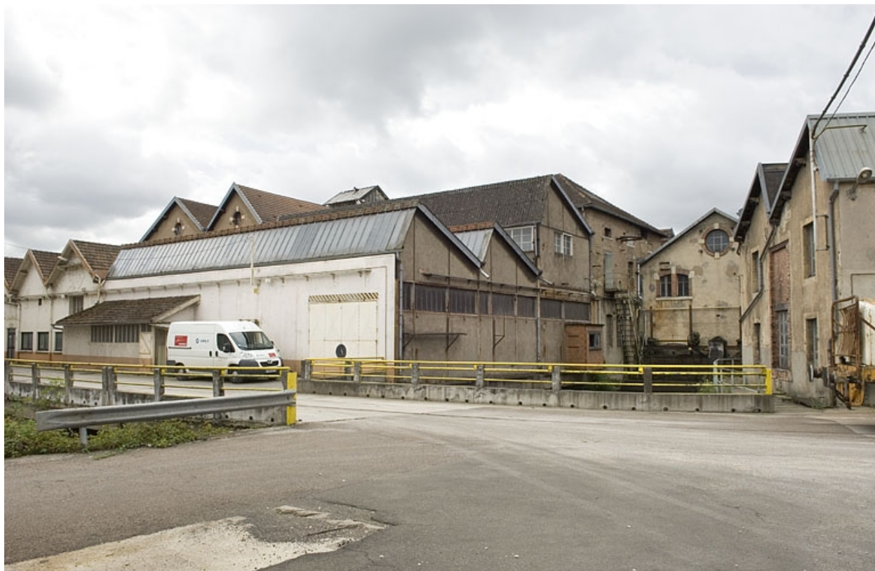
Atelier de fabrication (papeterie) et bâtiment d'eau.
