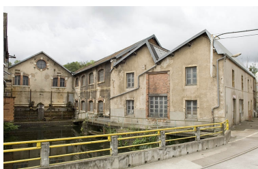
Bief d'amenée, bâtiment d'eau et atelier.
