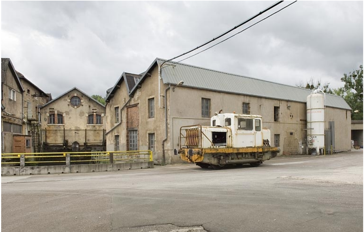
Bâtiment d'eau et atelier couvert de sheds.
