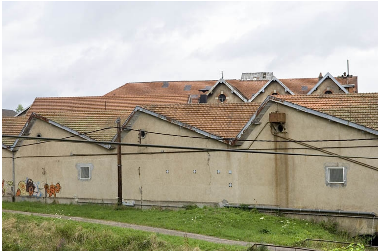
Façades sud des ateliers de fabrication.
