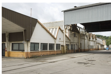
Façades nord des ateliers de fabrication.
