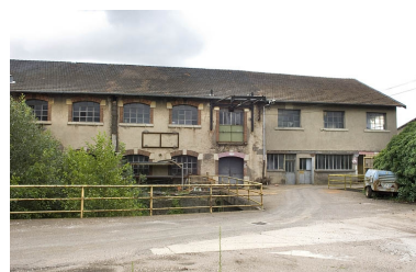
Façade ouest d'un atelier de fabrication (papeterie).
