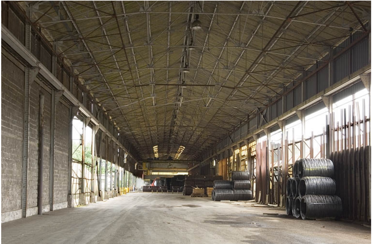
Vue intérieure d'un entrepôt industriel.
