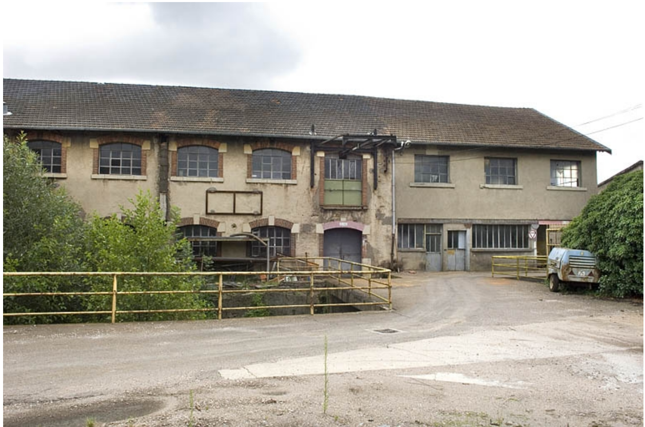
Façade ouest d'un atelier de fabrication (papeterie).
