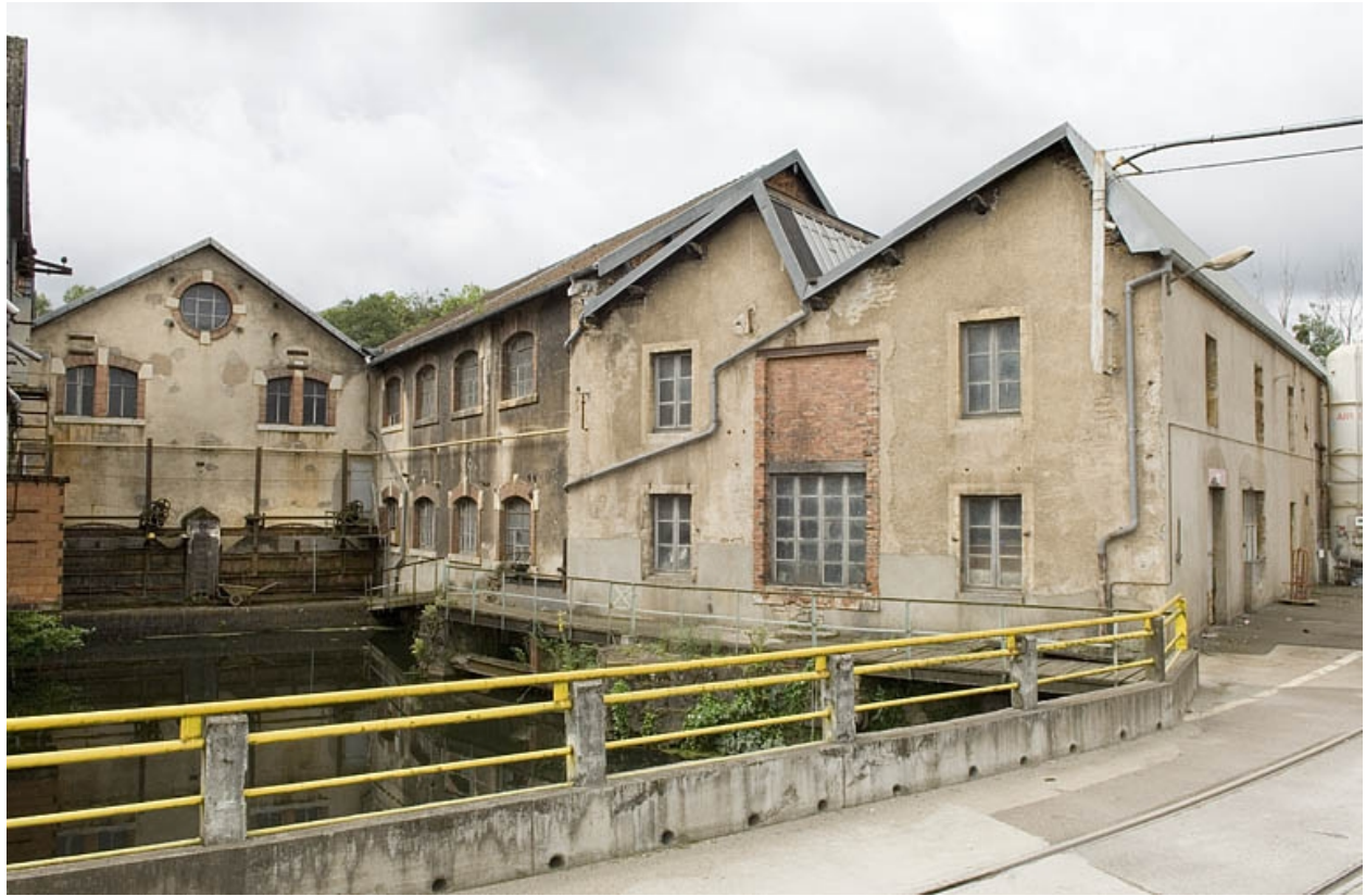
Bief d'amenée, bâtiment d'eau et atelier.
