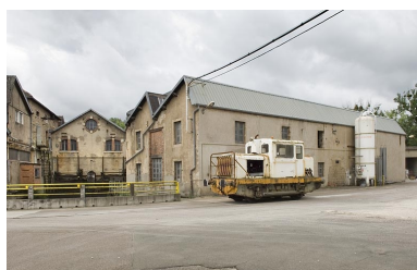
Bâtiment d'eau et atelier couvert de sheds.
