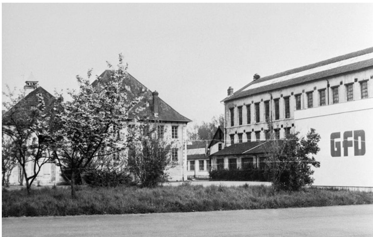
L'usine du Château en 1983 depuis l'ouest.
