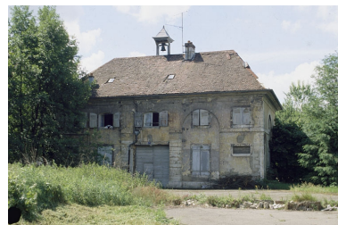
Façade postérieure des commons nord. Phot. Yves Sancey IVR43_20009000349ZA
