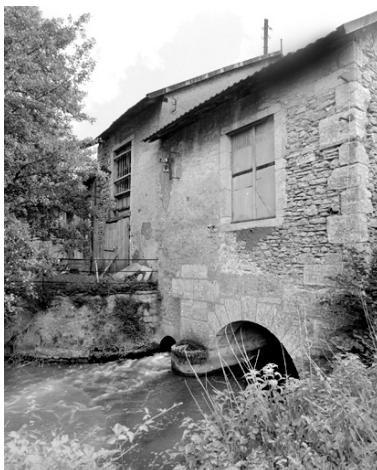
Canal de fuite et bâtiment d'eau.
