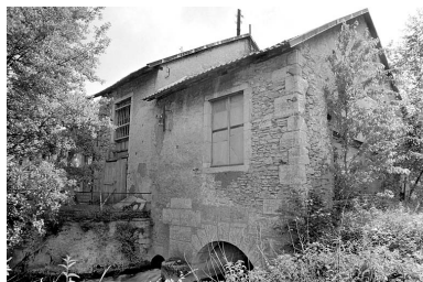
Salle des machines et bâtiment d'eau. Phot. Yves Sancey IVR43_20009000350X
