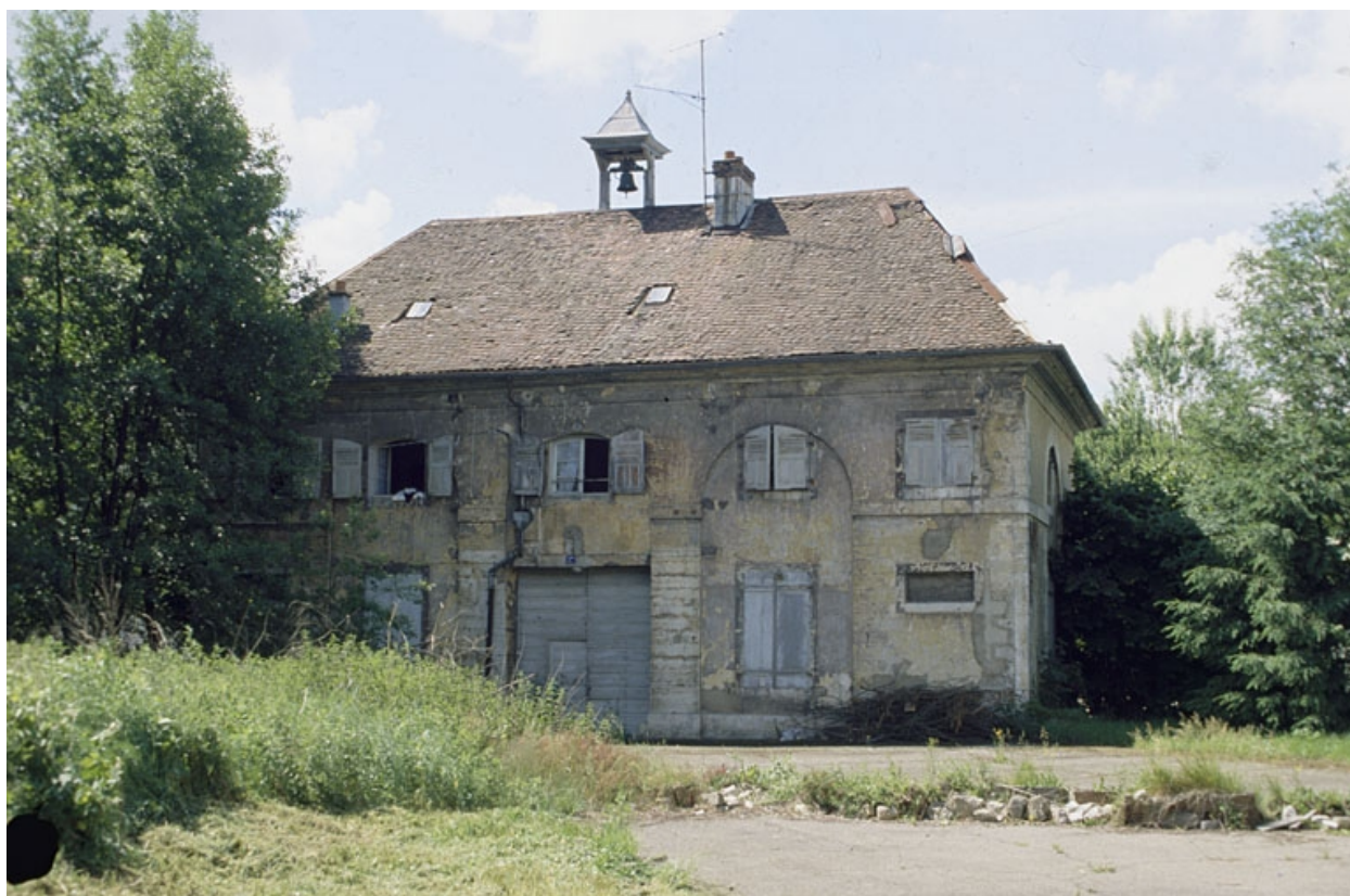
Façade postérieure des communs nord.
