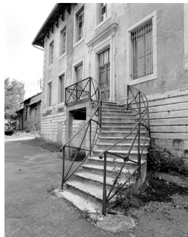
Volée droite de l'escalier. Phot. Yves Sancey IVR43_20009000343X
