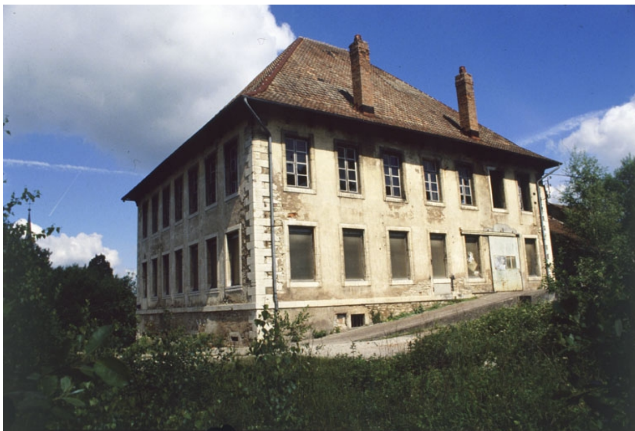
Vue de trois quarts arrière du château.
