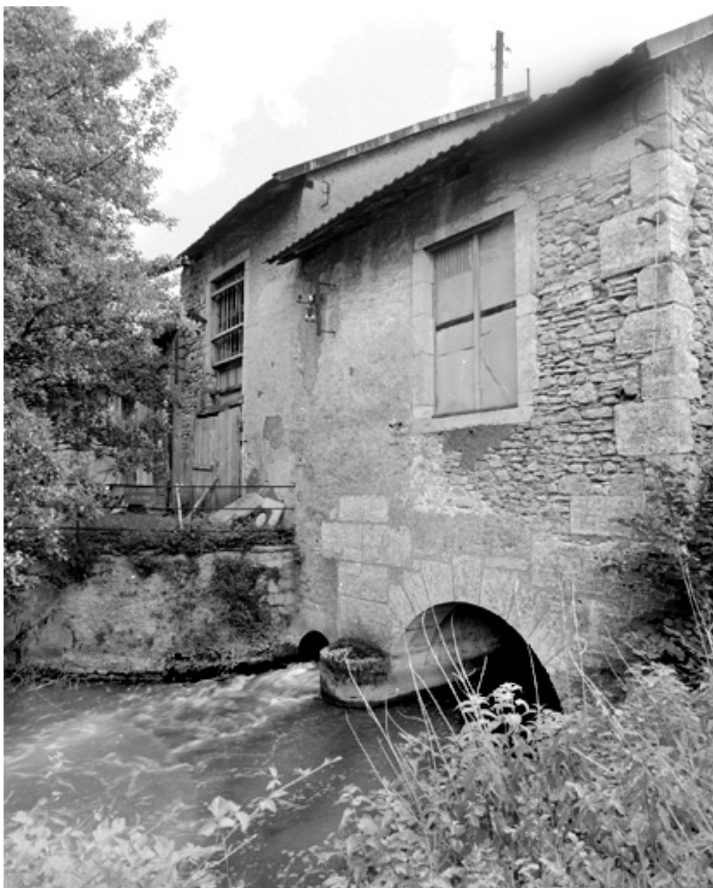
Canal de fuite et bâtiment d'eau.
