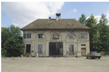
Bâtiment des commons nord. Phot. Yves Sancey IVR43_20009000347ZA
