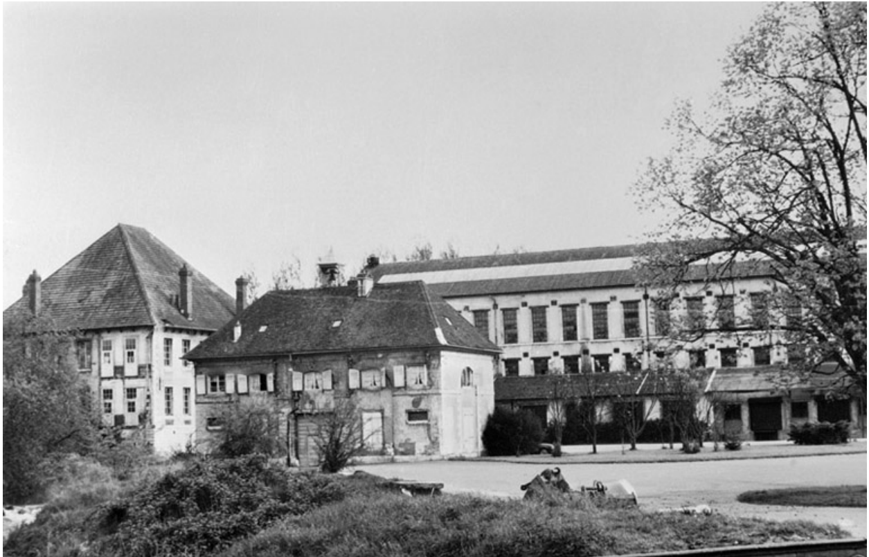
L'usine du Château en 1983.
