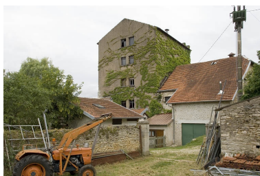
Façade postérieure. Phot. Jérôme Mongreville IVR43_20097000656NUC2A
