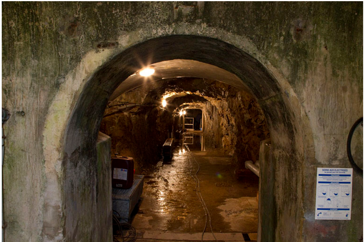
Tunnel d'amenée d'eau : galerie.
