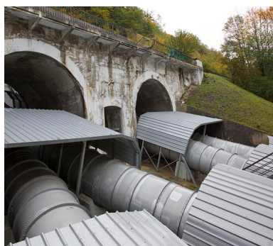
Conduites forcées à la sortie du pont de la route départementale, vues de trois quarts. Phot. Yves Sancey IVR43_20122502009NUC2A
