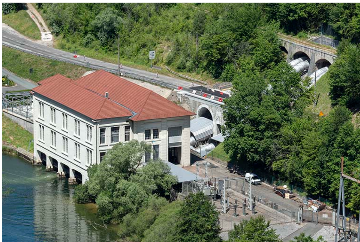
Vue d'ensemble plongeante resserrée, depuis le sud-est.
