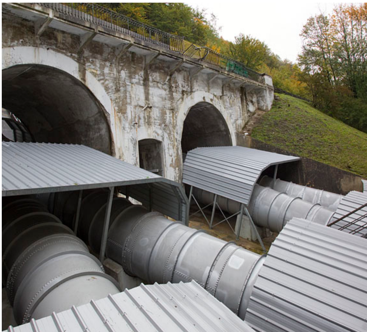
Conduites forcées à la sortie du pont de la route départementale, vues de trois quarts.
