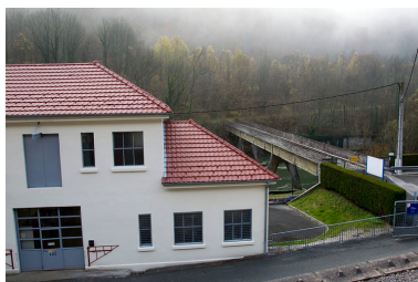
Atelier de réparation et passerelle. Phot. Yves Sancey IVR43_20122502042NUC2A
