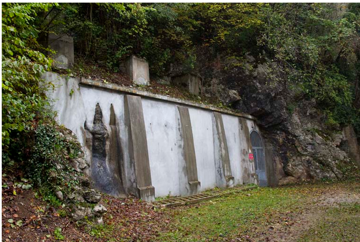
Tunnel d'amenée d'eau : tête aval.
