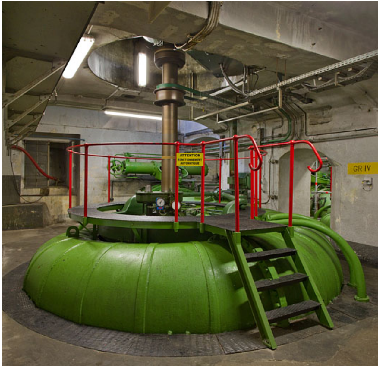
CenTrale : bête de la turbine du groupe n° 4 et axe de transmission, à l'étage de soubassement.
