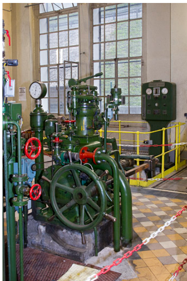
Centrale : régulateur de vitesse du groupe n° 4. Phot. Yves Sancey IVR43_20122502021NUC2A
