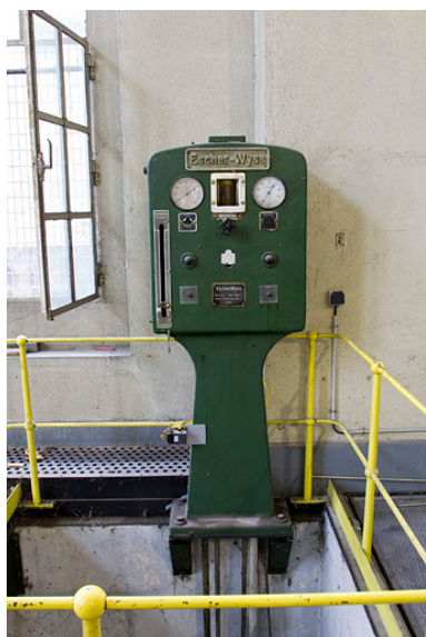
Centrale : commande de la vanne de pied du groupe n° 4. Phot. Yves Sancey IVR43_20122502020NUC2A
