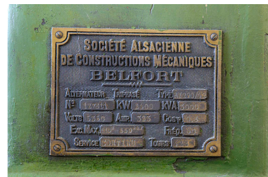
Centrale : plaque signalétique de l'alternateur du groupe n° 1 Phot. Yves Sancey IVR43_20122502023NUC2A
