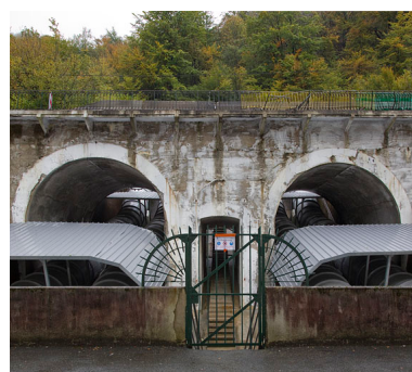
Conduites forcées sous le pont de la route départementale. Phot. Yves Sancey IVR43_20122502008NUC2A
