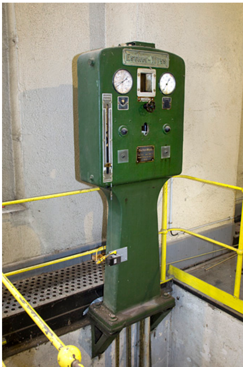
Centrale : commande de la vanne de pied du groupe n° 4., de trois quarts
