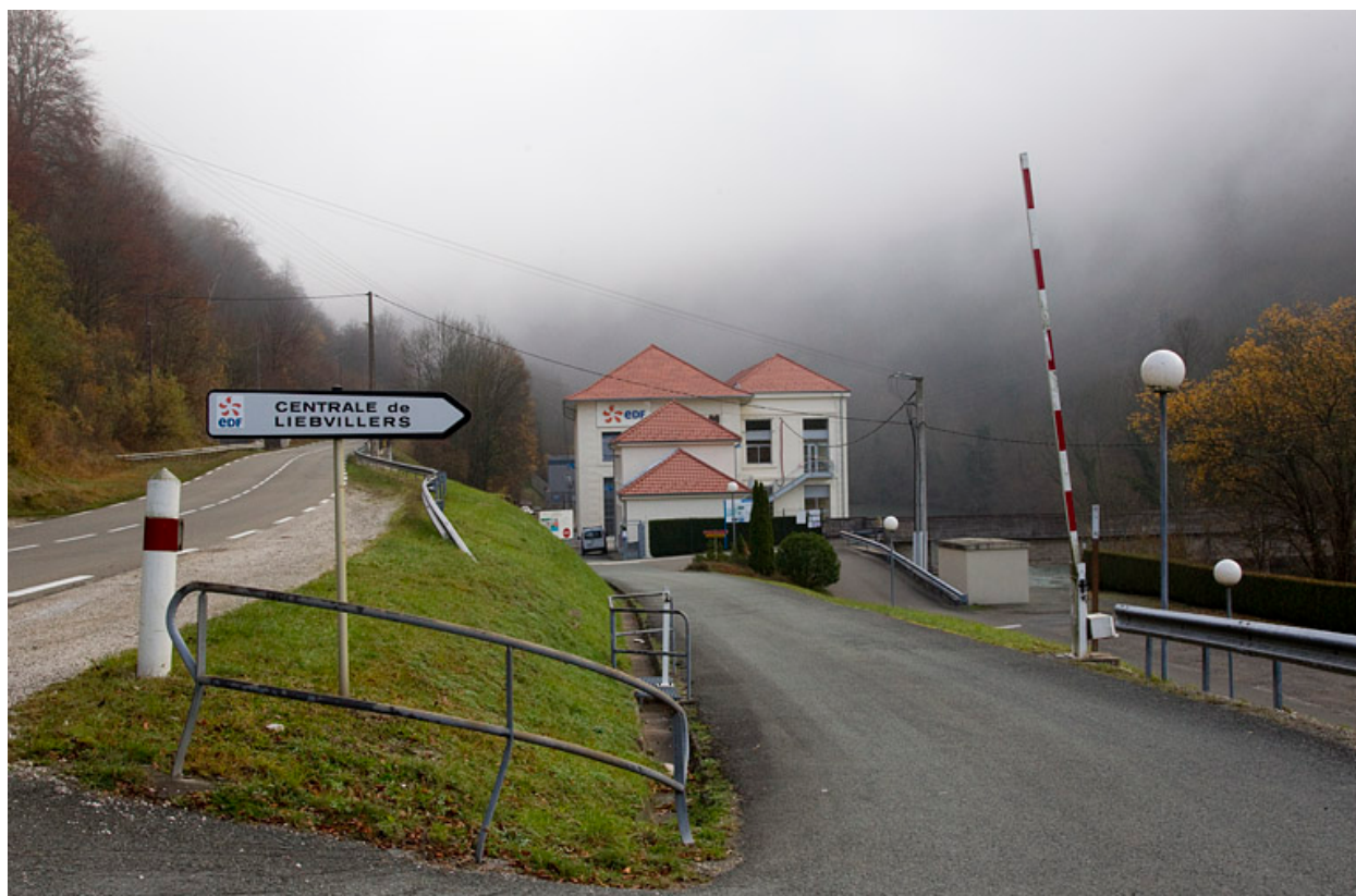
Vue d'ensemble depuis l'ouest (aval rive droite).
