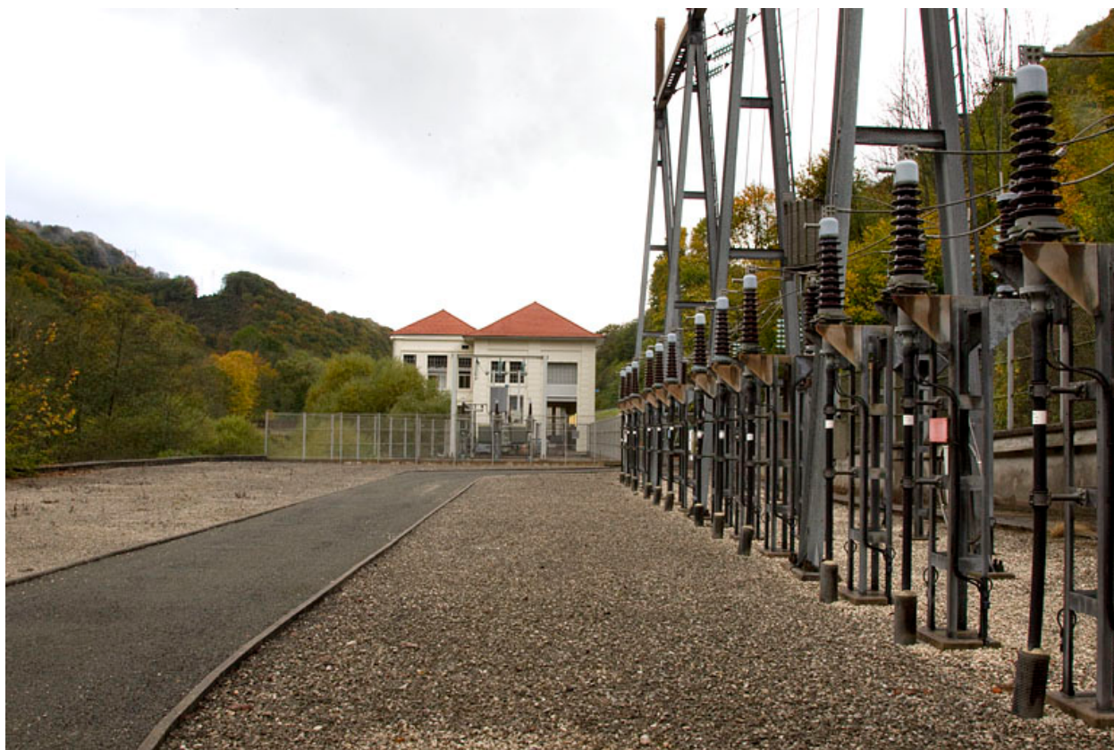
Vue d'ensemble depuis l'est (amont rive droite).
