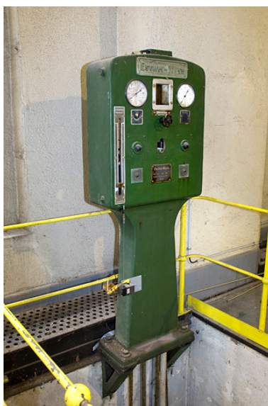
Centrale : commande de la vanne de pied du groupe n° 4., de trois quarts Phot. Yves Sancey IVR43_20122502019NUC2A
