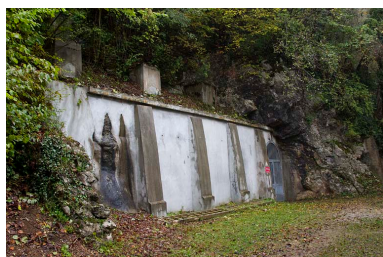
Tunnel d'amenée d'eau : tête aval. Phot. Yves Sancey IVR43_20122502039NUC2A
