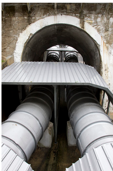
Conduites forcées à la sortie du pont sous la route départementale. Phot. Yves Sancey IVR43_20122502025NUC2A
