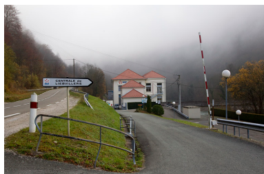
Vue d'ensemble depuis l'ouest (aval rive droite). Phot. Yves Sancey IVR43_20122502040NUC2A
