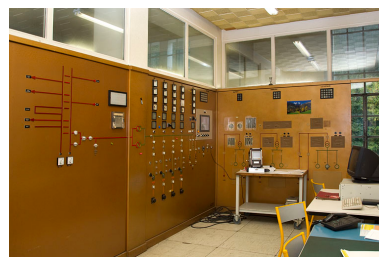
Centrale : poste de commande des centrales de Liebvillers, Dampjoux, Vaufrey et le Refrain. Phot. Yves Sancey IVR43_20122502026NUC2A
