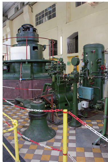
Centrale : régulateur de vitesse du groupe n° 4. Phot. Yves Sancey IVR43_20122502031NUC2A
