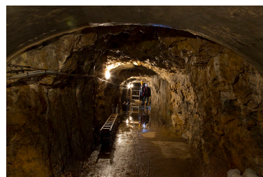
Tunnel d'amenée d'eau : galerie d'accès à la cheminée d'équilibre. Phot. Yves Sancey IVR43_20122502037NUC2A
