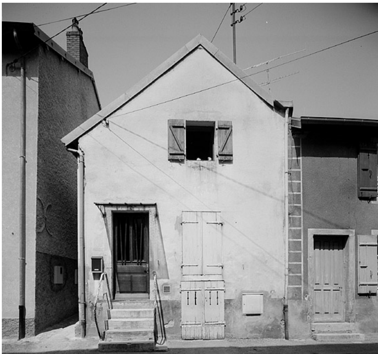
Façade antérieure de face.
