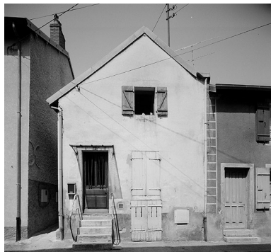
Façade antérieure de face.
