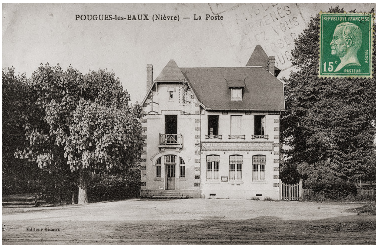
Façade, vue de face.
