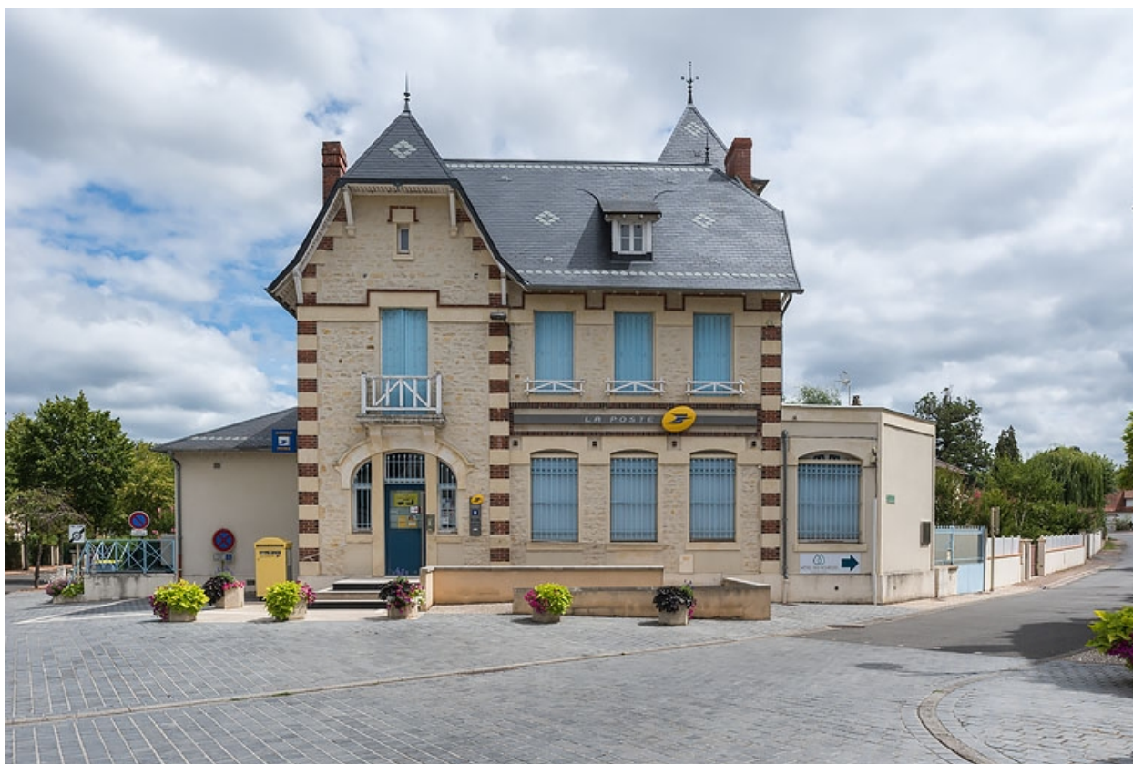
Façade, vue de face.
