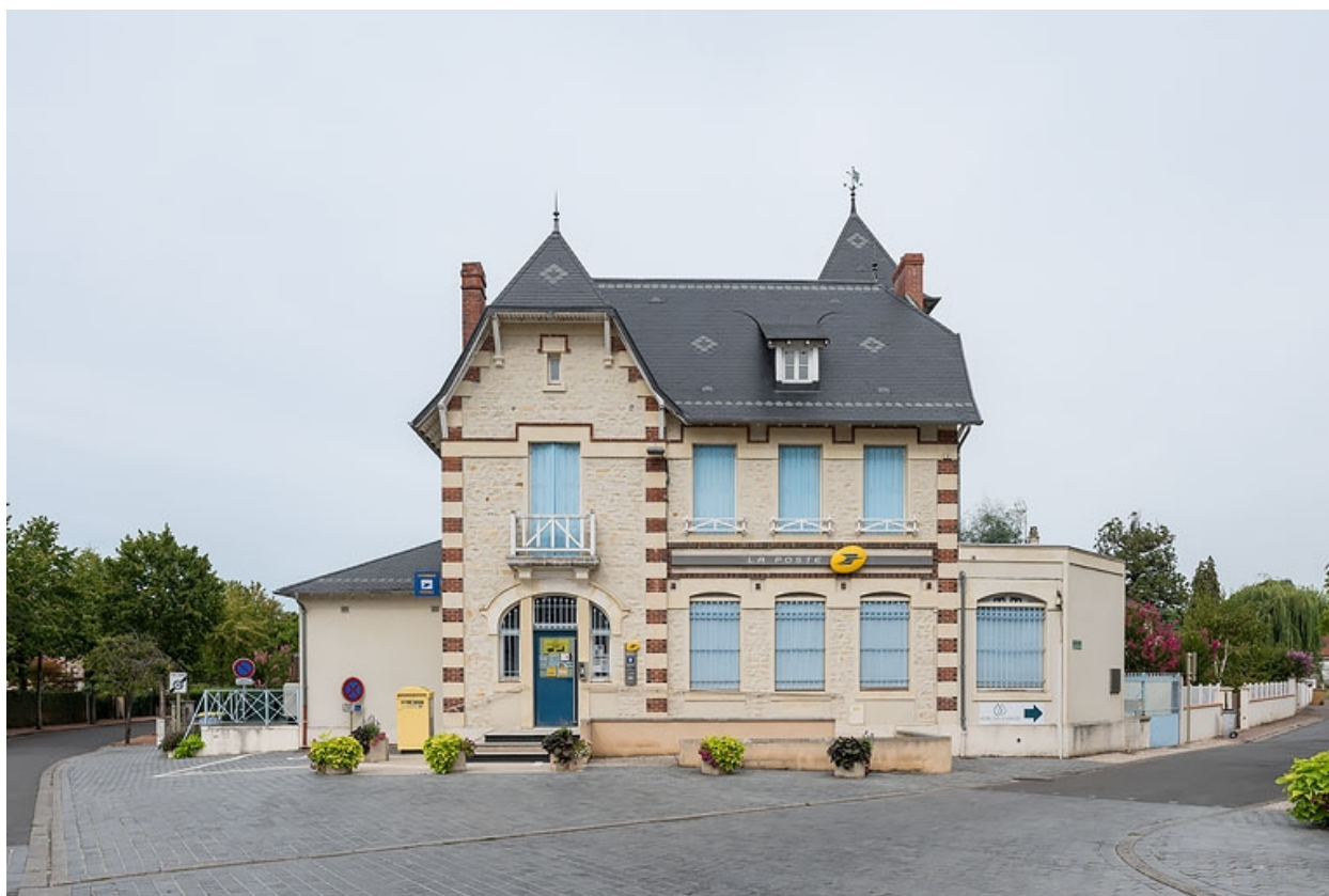
Façade, vue de face.
