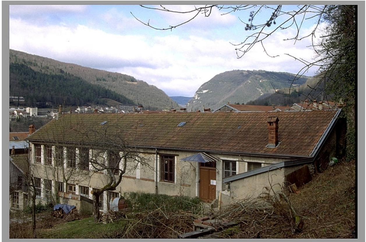
Atelier de fabrication de trois quarts droite.
