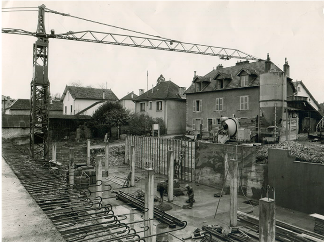
Chantier de construction de l'usine B, fotogr., 1961.
