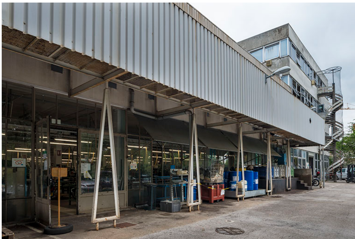
Usine B (12 rue du Tunnel). Façade est.
