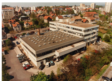
Vue plongeante depuis le sud, photogr., s.d. [vers 1990]. IVR43_20182500888NUC4A
