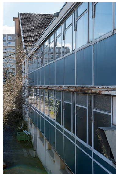
Façade orientale de l'extension nord. Phot. Jérôme Mongreville IVR43_20182500567NUC4A
