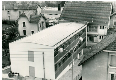
Extension nord de l'usine- mère, fotogr., s.d. [vers 1970]. IVR43_20182500894NUC4A
