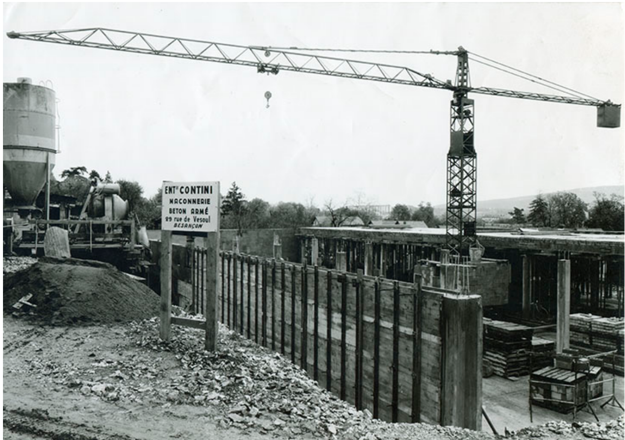
Chantier de construction de l'usine B, fotogr., 1961.
