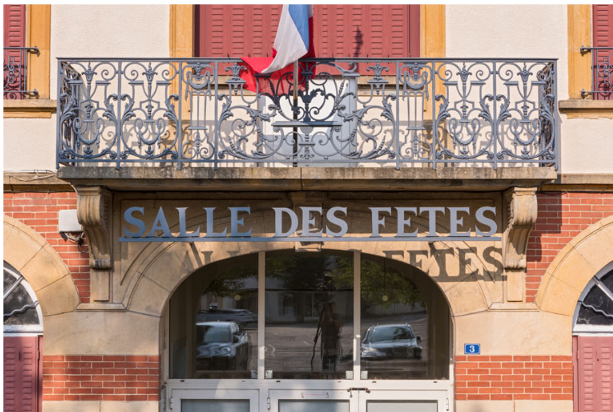
Façade antérieure : enseigne et balcon.
