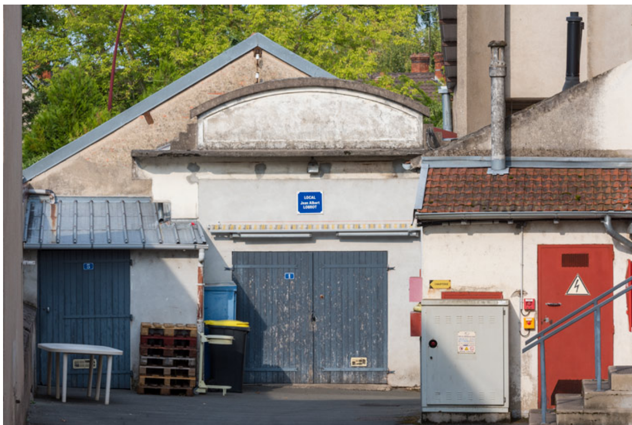
Garage en fond de cour, au nord-est.
