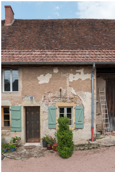
Vue partielle de la façade antérieure de la seconde maison. Cette partie de la maison, autrefois étable, a connu plusieurs modifications de ses ouvertures. Au-dessus de la fenêtre, une chaîne indique l'emplacement d'une ancienne baie, qui servait peut-être à l'aération du fenil. Phot. Pierre-Marie Barbe-Richaud IVR26_20197100297NUC4A
