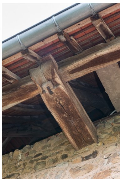
Cette solive, sur laquelle repose le plancher des combles de la maison, forme encorbellement et soutien le débord du toit. Le trou (ou mortaise) indique qu'un pilier en bois venait s'assembler avec la solive. Ce pilier était un élément de la galerie qui se développait à l'origine au premier étage de la façade de la maison. Phot. Pierre-Marie Barbe-Richaud IVR26_20197100290NUC4A
