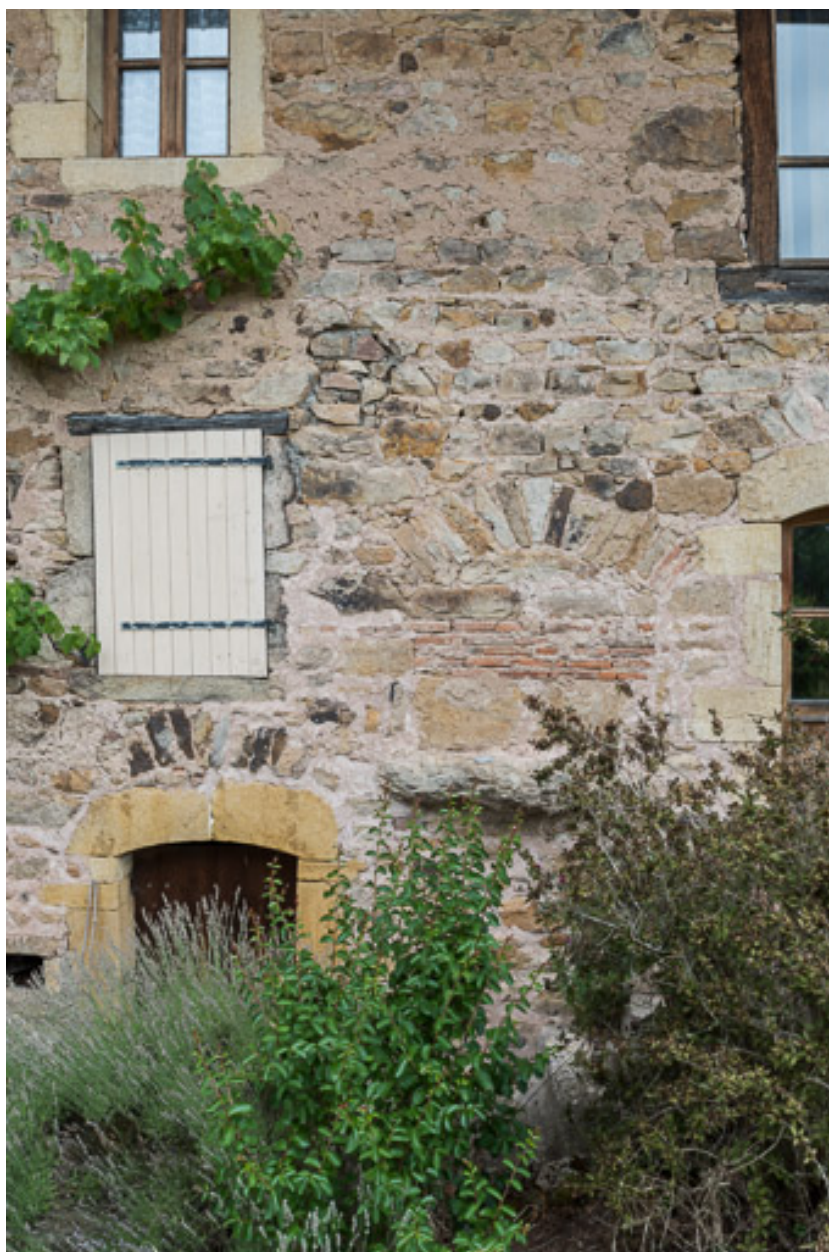
Détail de la façade antérieure de la maison. Au centre, l'évacuation de la pierre d'évier.
