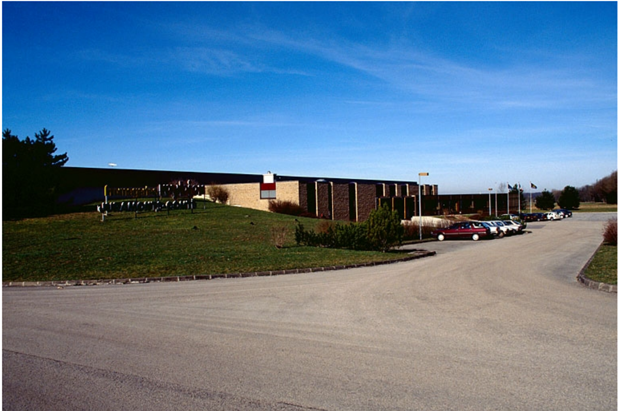
Chaufferie, quai d'expédition et bureaux depuis l'entrée.
