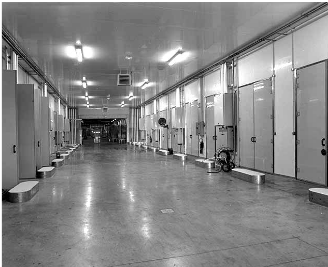
Couloir central des pièces d'affinage.
