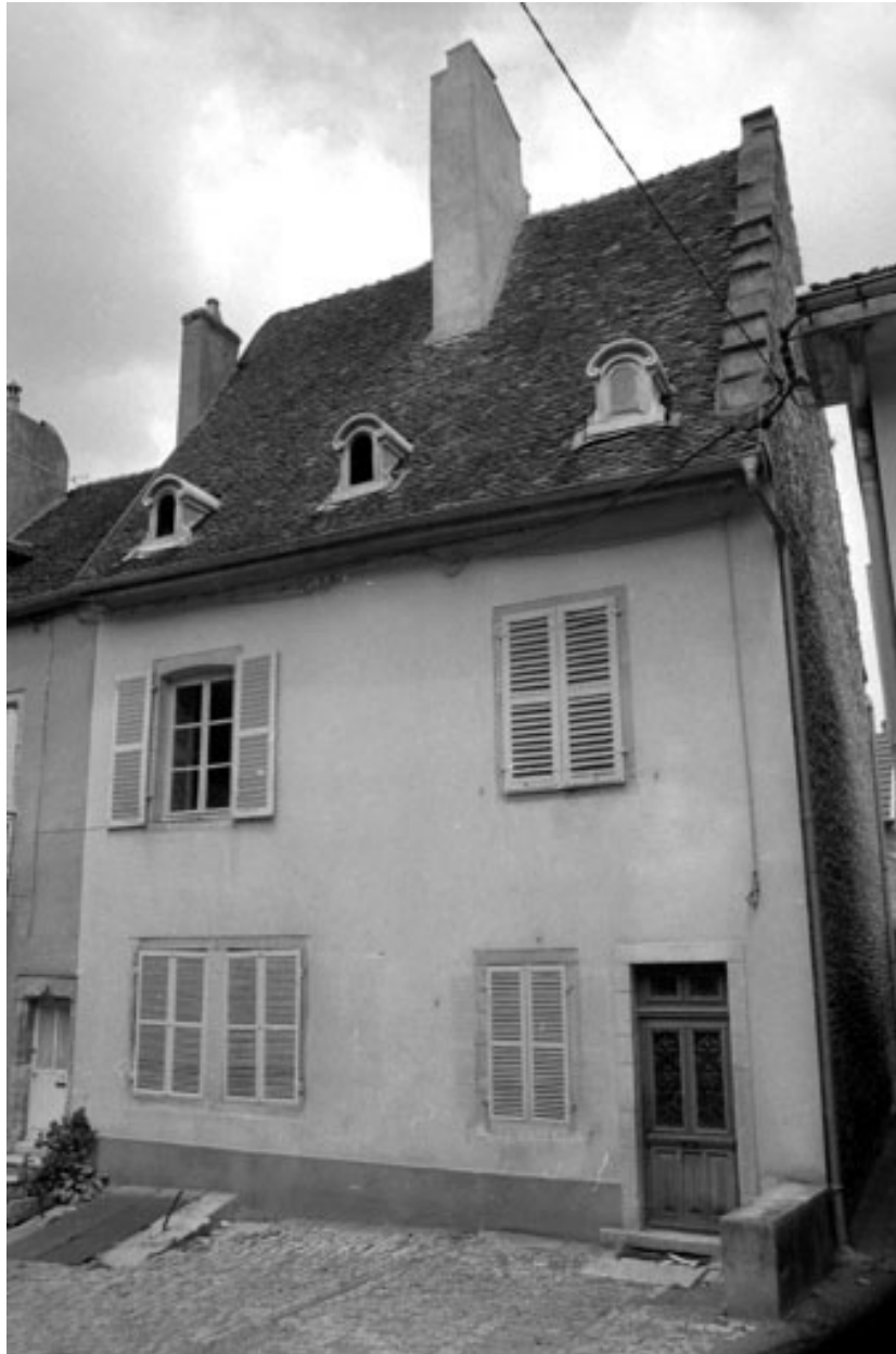
Façade antérieure de l'habitation sur rue Saint-Hilaire.
