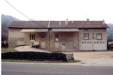
Vue d'ensemble. Phot. Jérôme Mongreville IVR43_19963900070ZA
