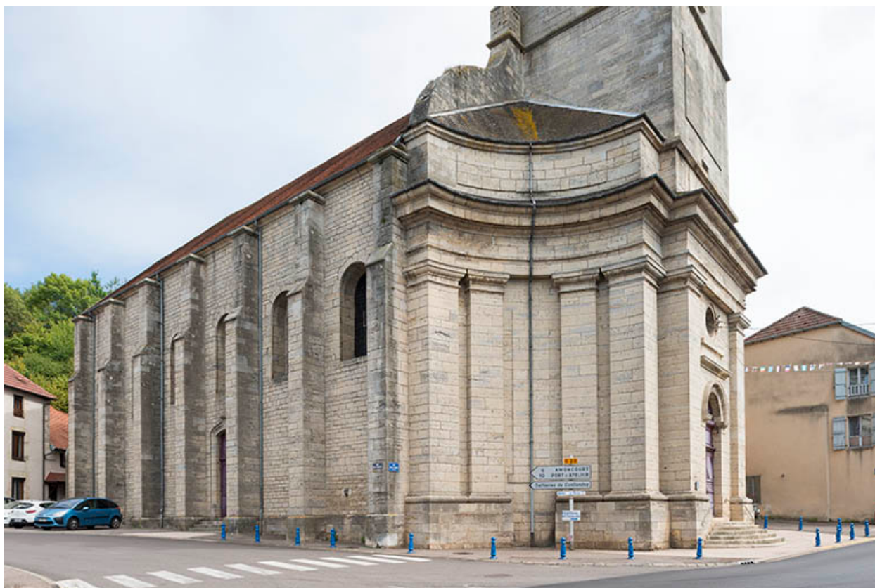
Le mur latéral ouest de l'édifice.
