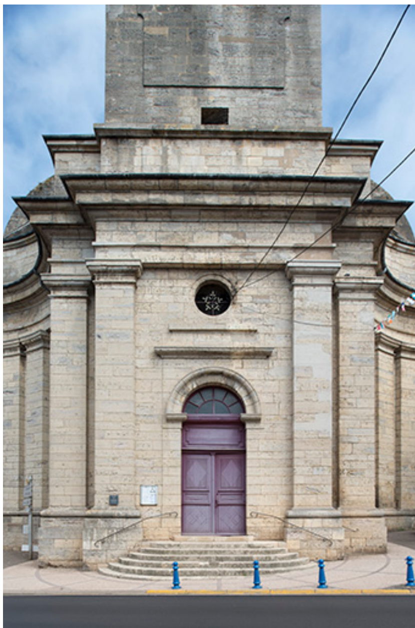
La façade principale et le portail d'entrée.
