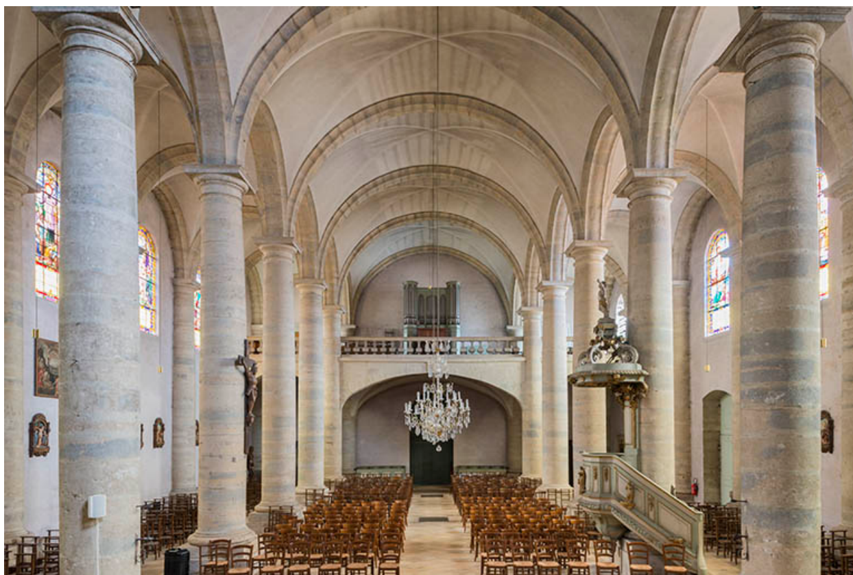
Vue générale de l'église de type halle.
