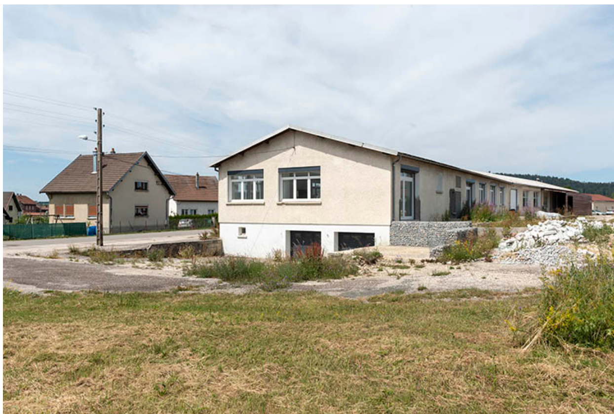
Façades postérieure et latérale droite.
