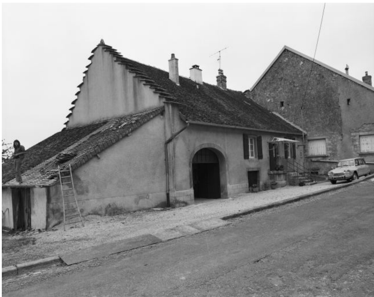
Ferme située rue de l'Eglise.
