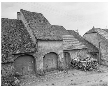
Ferme située chemin des Vignes. Phot. Yves Sancey IVR43_19813900190X
