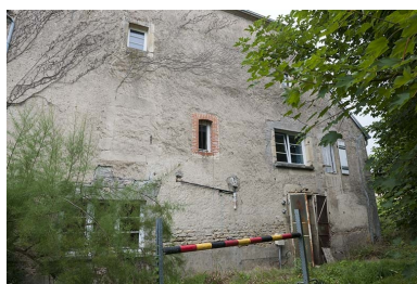
Façade latérale droite de la maison. Phot. Jérôme Mongreville IVR43_20127000674NUC4A
