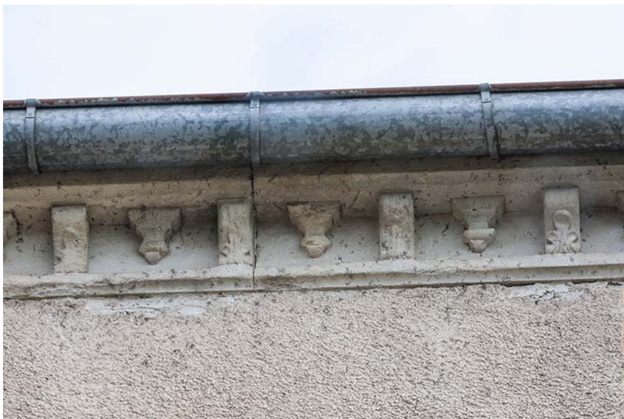
Détail de la corniche de la maison.
