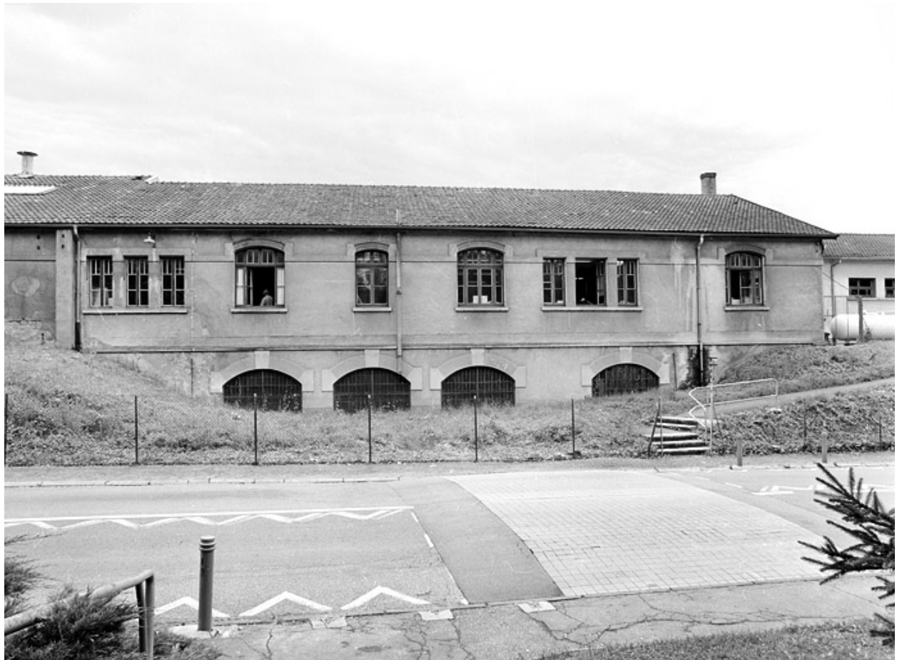
Façade postérieure des ateliers de fabrication.
