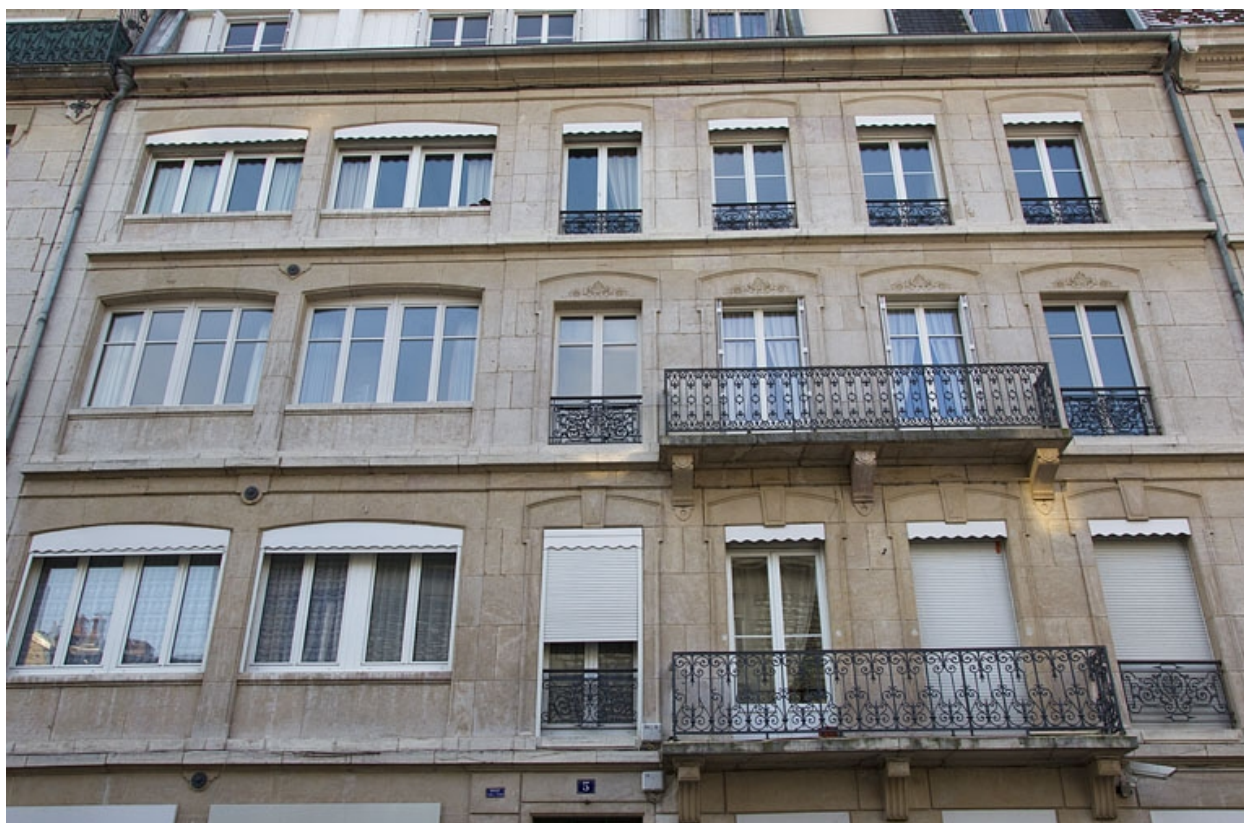
Vue d'ensemble de la façade, de face.
