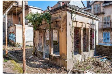
Pavillon de l'ancien jardin. Phot. Jérôme Mongreville IVR43_20227000091NUC4A
