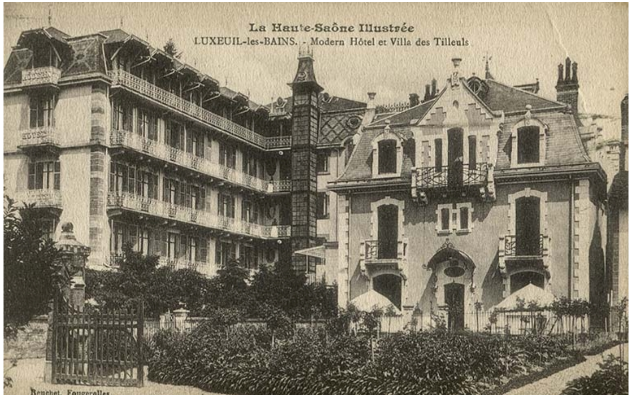
Façade sur l'allée des Romains (vers 1920).
