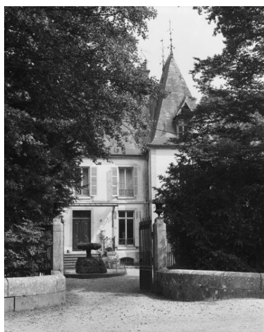
Entrée du château. Phot. Dominique Dominguez IVR43_19803900273X
