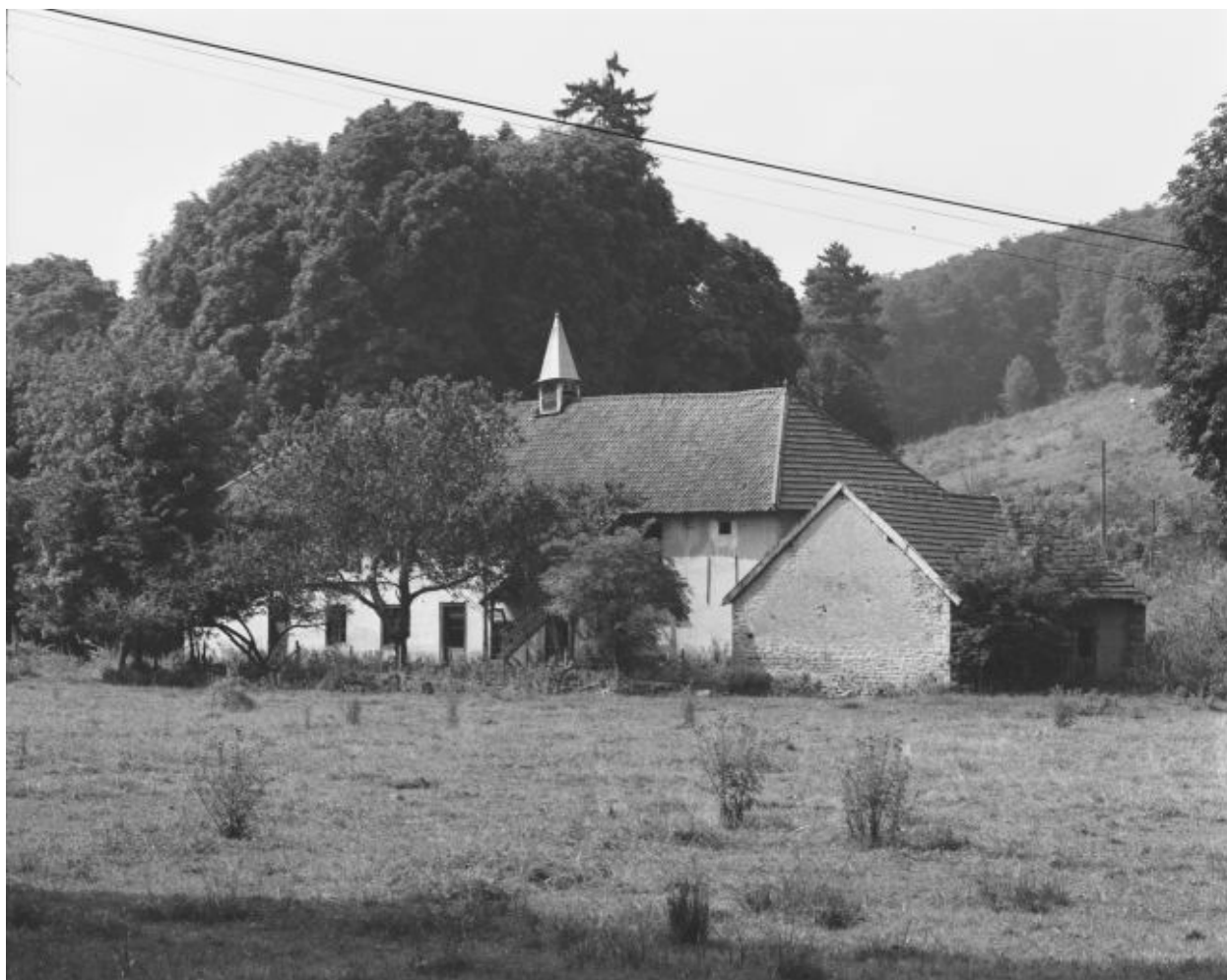
Façade postérieure du presbytère.
