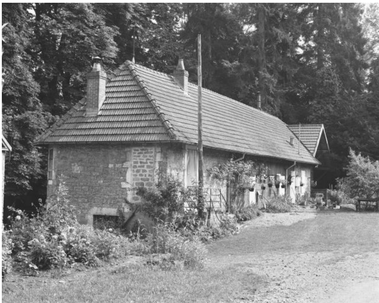
Logement ouvrier vu de trois quarts gauche.
