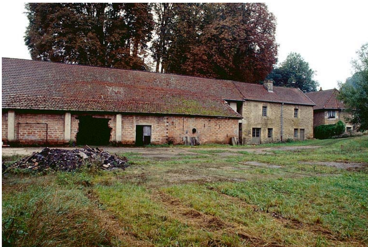
Atelier de fabrication (?), vu depuis le nord.
