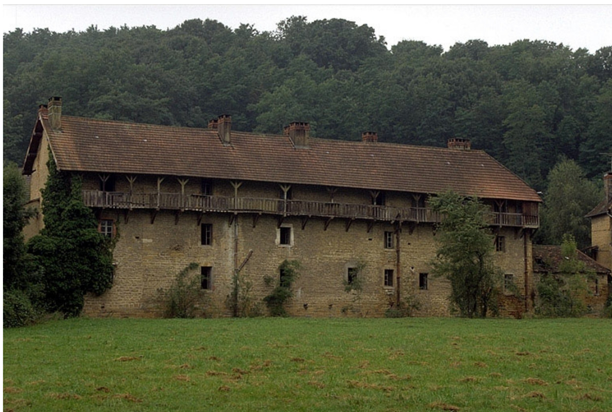
Logement d'ouvriers (D).Façade postérieure longeant la Brenne.
