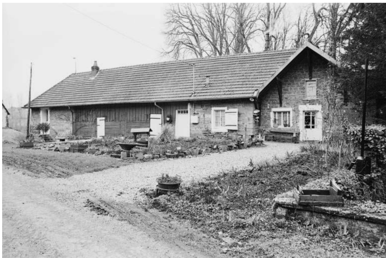
Façade antérieure d'un logement ouvrier.
