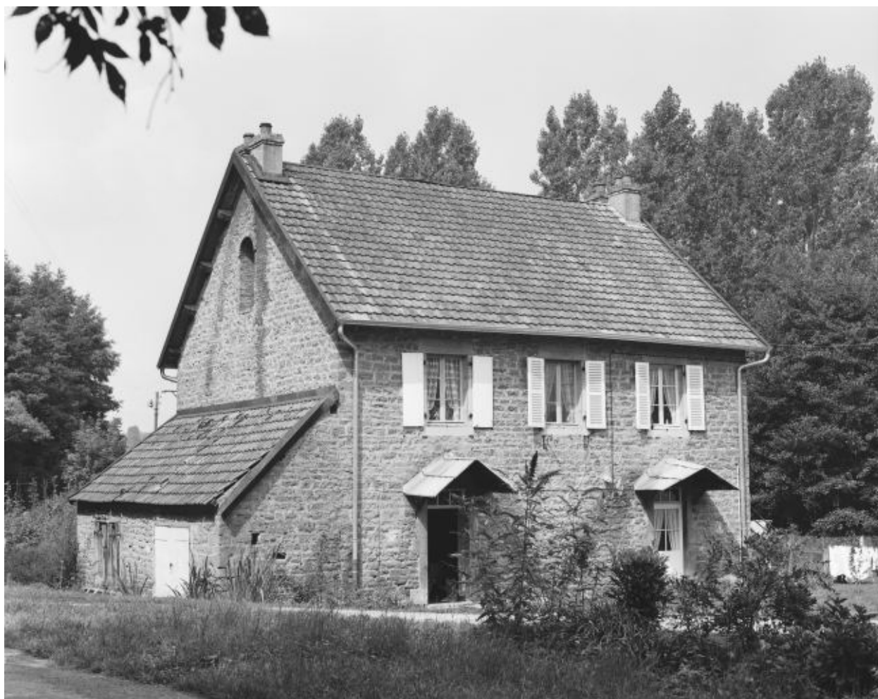
Logement d'ouvriers (B) en 1980.
