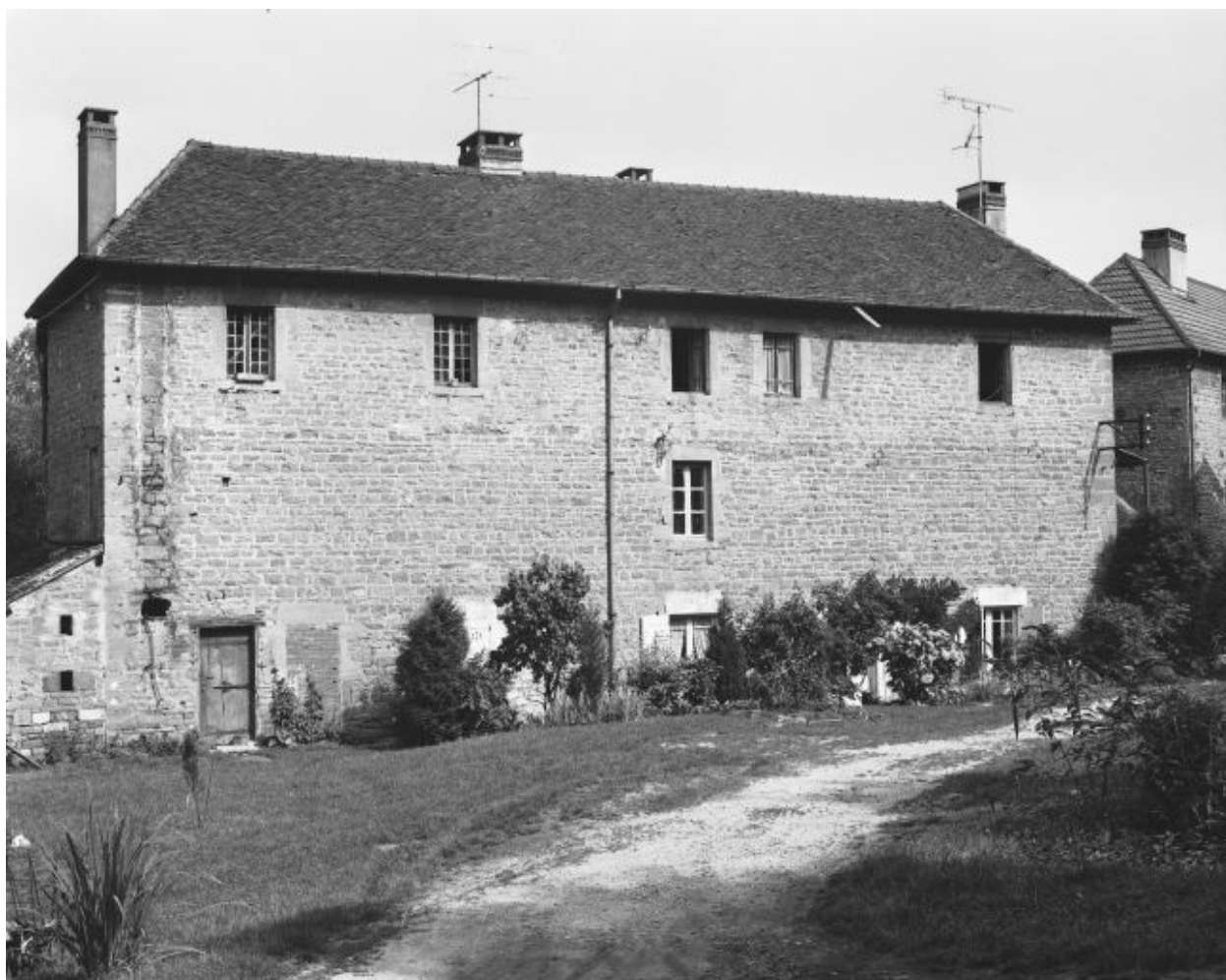
Façade antérieure d'un logement ouvrier.
