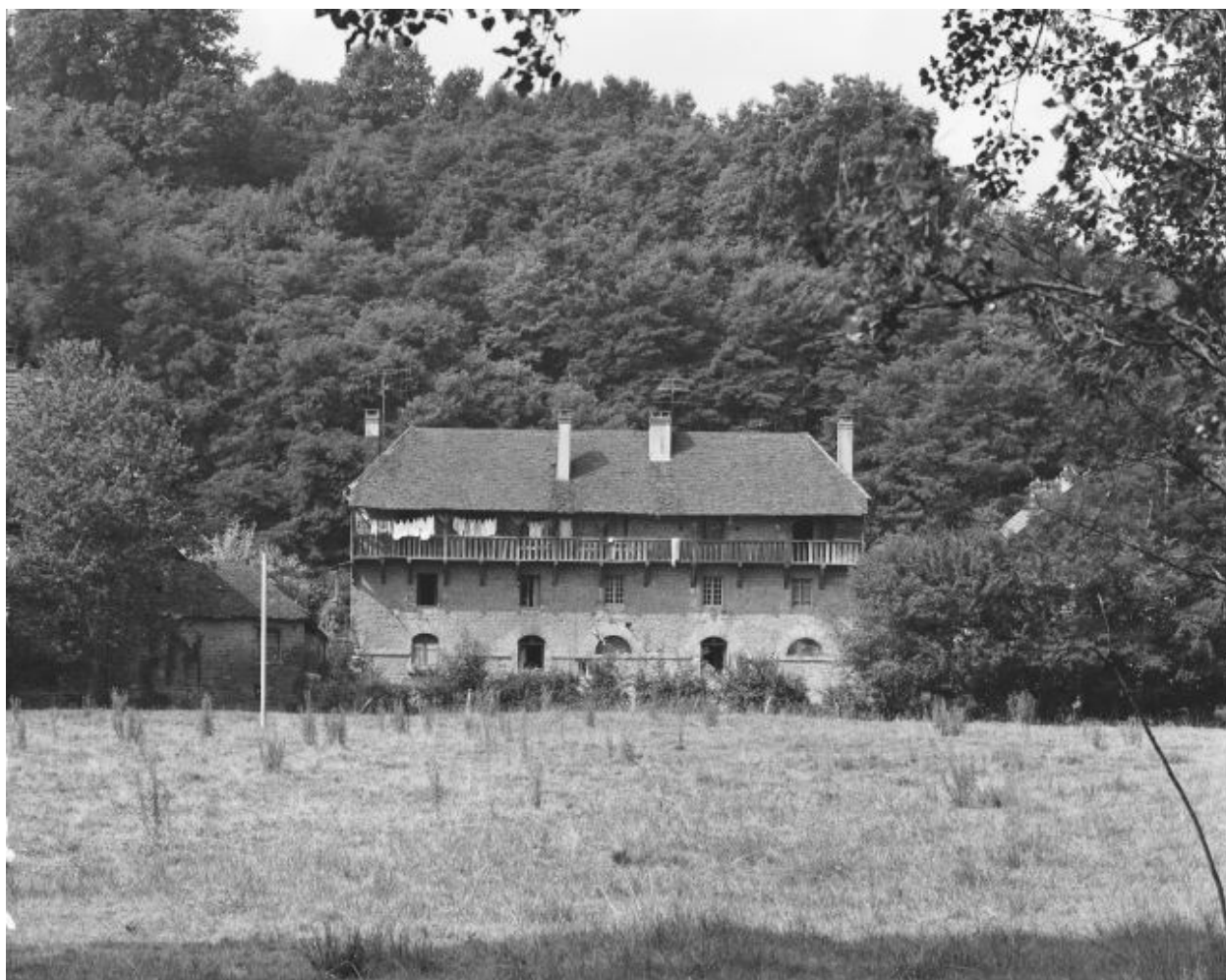
Façade postérieure d'un logement ouvrier.
