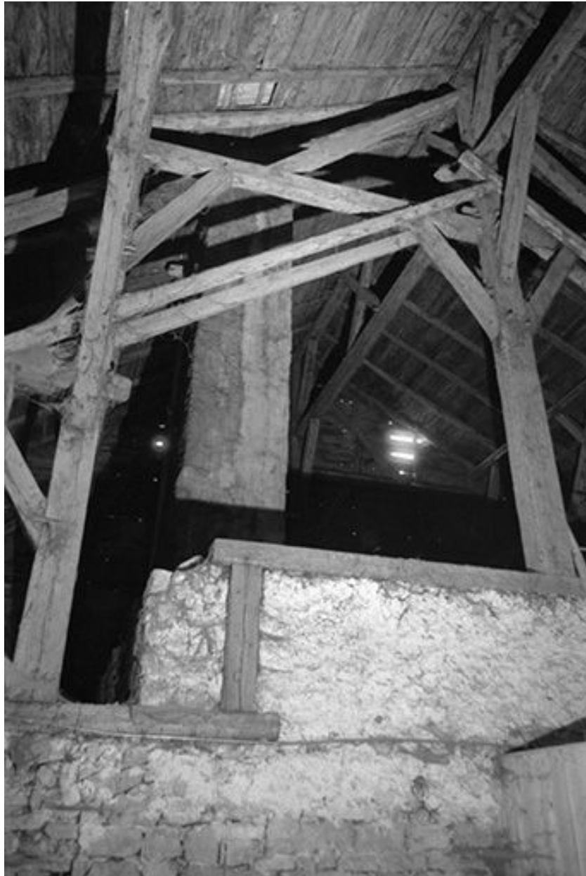
Intérieur : charpente et cheminée.
