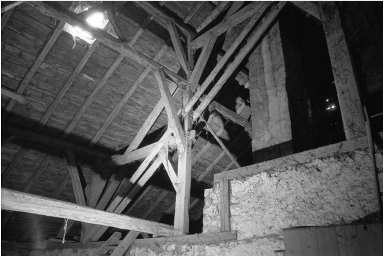
Intérieur : charpente et cheminée.
