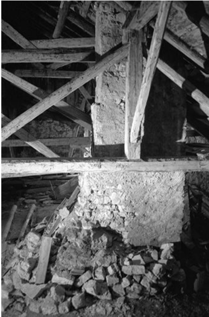
Intérieur : charpente et cheminée.
