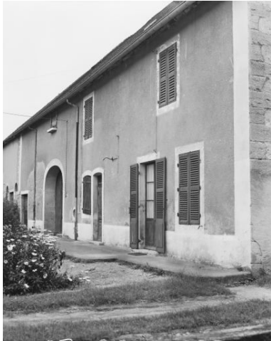
Façade antérieure. Phot. Dominique Dominguez IVR43_19803900263X
