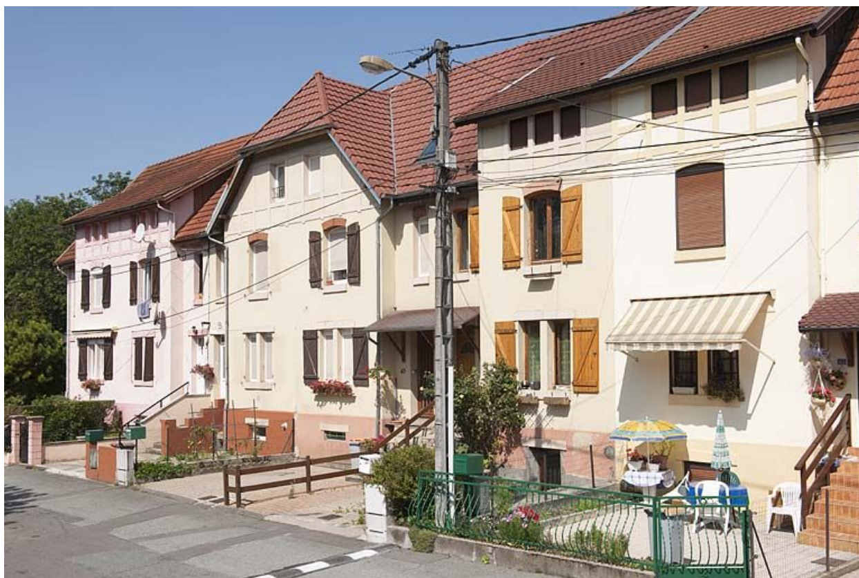
Rue de Somme. Extrémité occidentale de l'immeuble.
