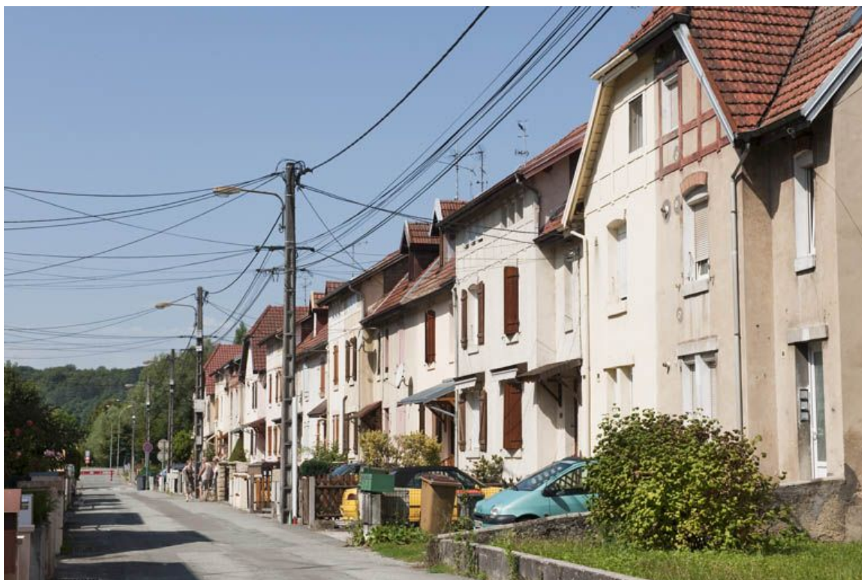
Rue de Somme. Façades sud.
