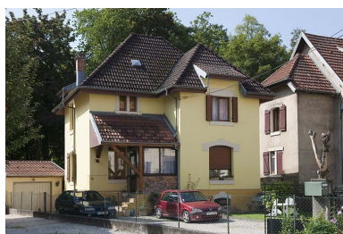
Maison individuelle rue de Flandres. Phot. Jérôme Mongreville IVR43_20112502070NUC4A
