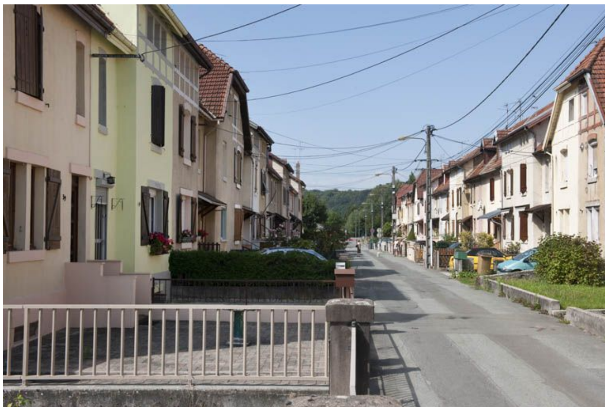
Rue de Somme. Vue d'ensemble.
