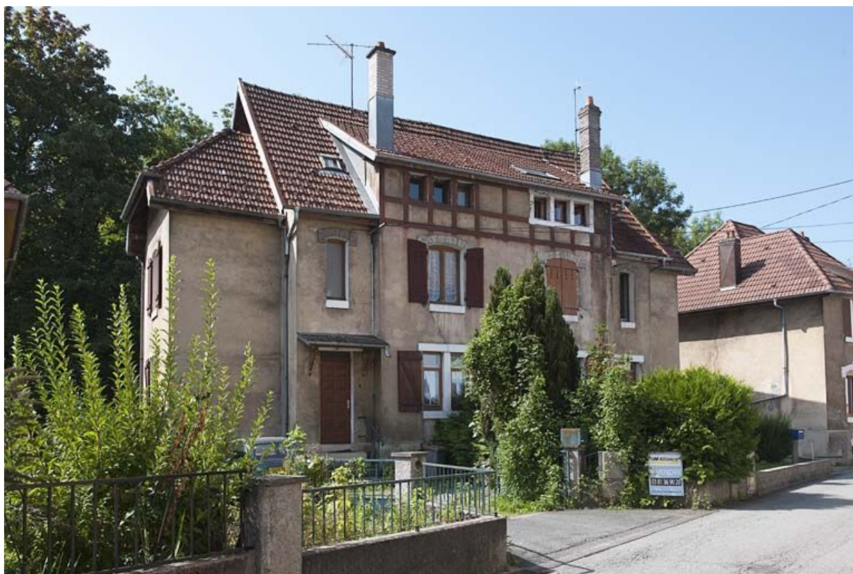
Maison jumelée rue de Flandres.
