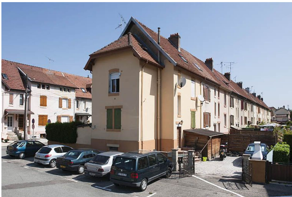
Immeuble rue de Flandres depuis le sud-ouest.
