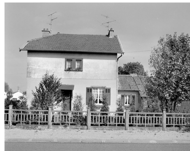
Face latérale droite. Phot. Yves Sancey IVR43_19893900538X
