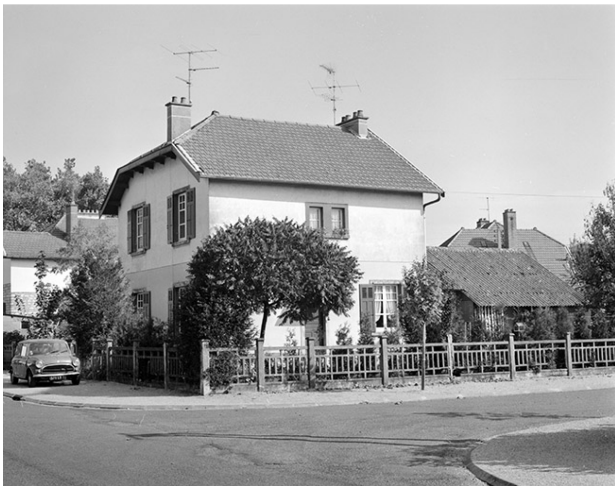
Façade antérieure et face latérale droite.
