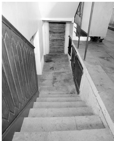
Escalier : volée menant au sous- sol. Noter les trois niches à droite. Phot. Yves Sancey IVR43_20033900772X
