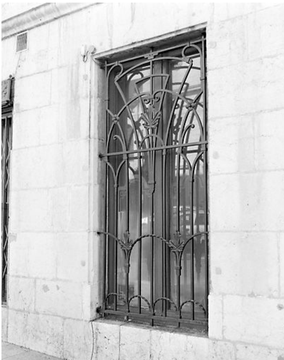
Façade latérale gauche : grille Art déco.
