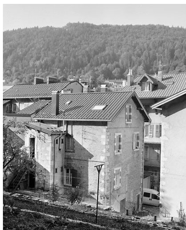
Bâtiment sud, vu du jardin. Phot. Yves Sancey IVR43_20033900766X
