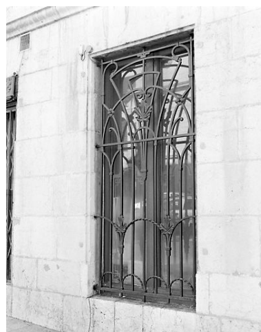
Façade latérale gauche : grille Art déco. Phot. Yves Sancey IVR43_20033900768X
