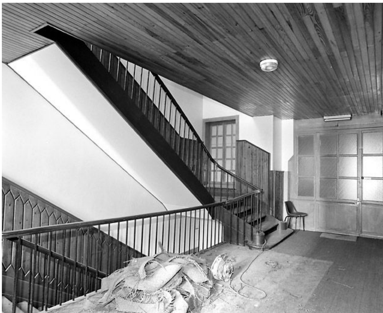
Escalier : un palier.
