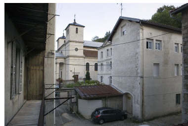
Bâtiment nord et cour. Phot. Yves Sancey IVR43_20093900136NUC2A
