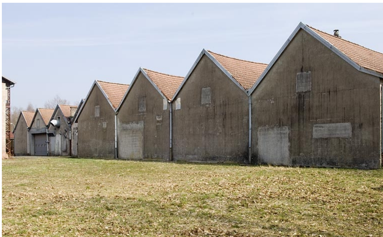
Pignons ouest de l'atelier de filature.
