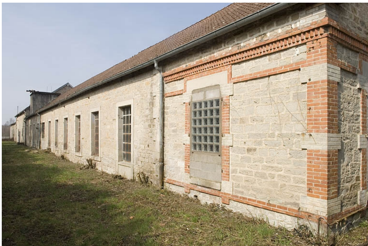
Façade sud vue de trois quarts droite.
