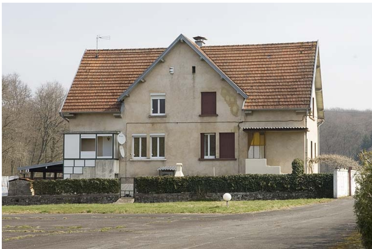
Logement de cadres (?). Façade postérieure.
