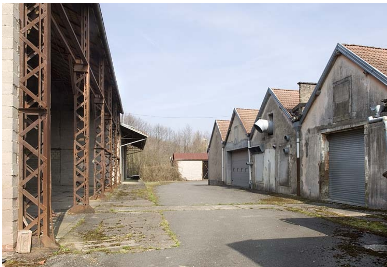
Entrepôt industriel et atelier de filature.
