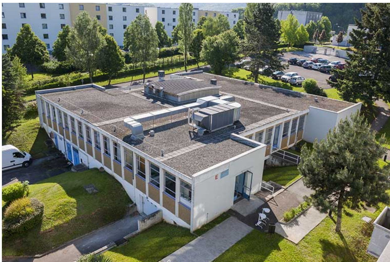
Angle nord-ouest du bâtiment de restauration.
