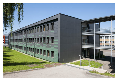
Façade sud et pignon est de l'externat. Phot. Jérôme Mongreville IVR43_20132500708NUC4A
