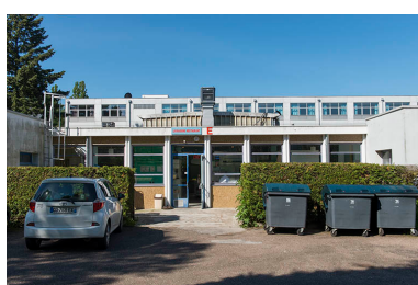
Façade postérieure est du bâtiment de restauration. Phot. Mary Ruffinoni IVR43_20132500686NUC4A
