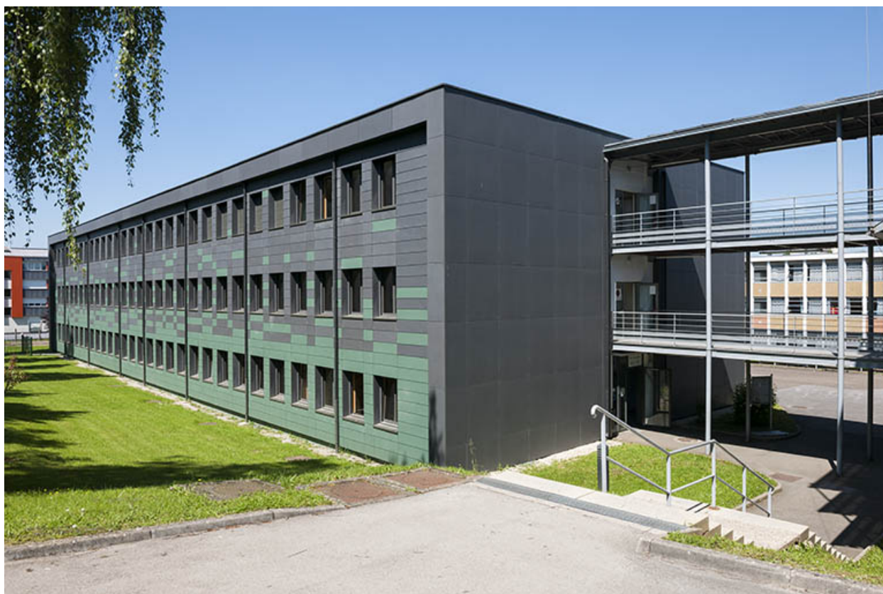
Façade sud et pignon est de l'externat.
