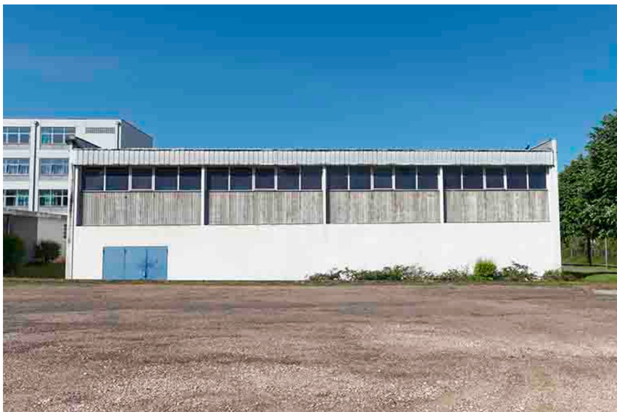
Façade nord-est du gymnase.
