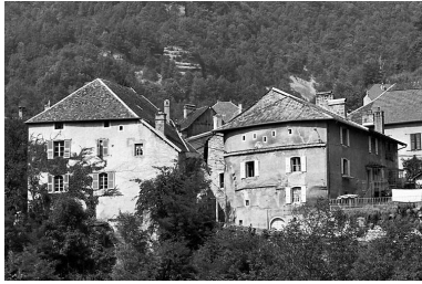
Elévation depuis le sud. Phot. Yves Sancey IVR43_19802500987X
