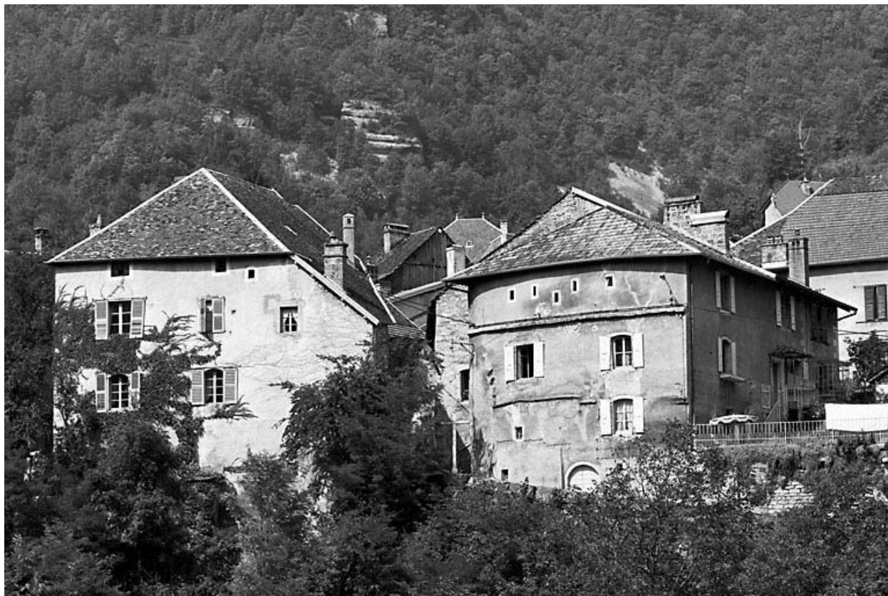
Elévation depuis le sud.
