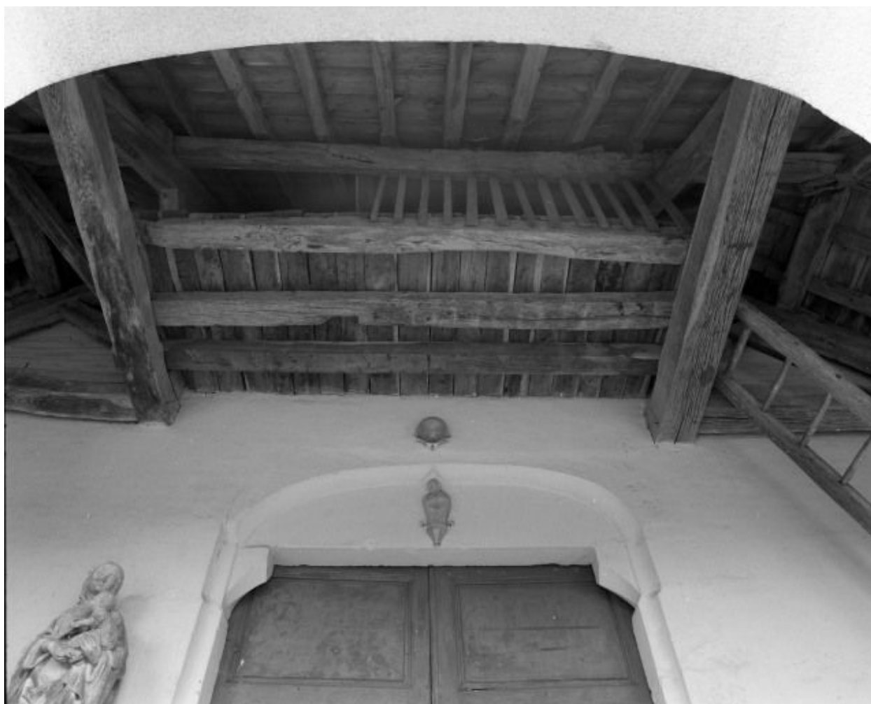
Porche, galerie permettant l'accès au clocher.
