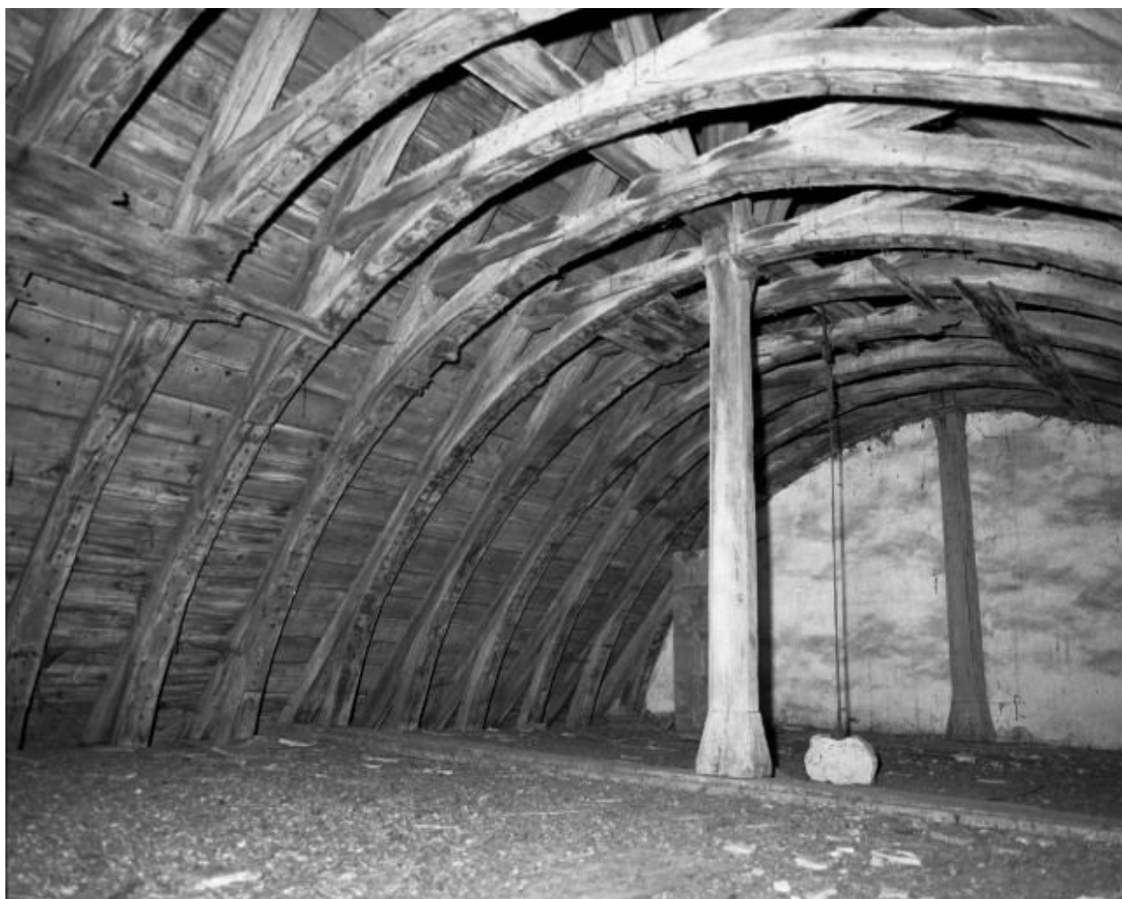
Comble du choeur, partie gauche.
