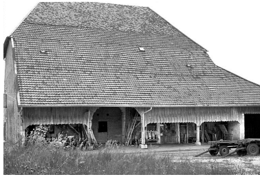
Vue du mur long-pan sur rue. Phot. Gilbert Poinot IVR43_19752500732Z
