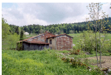
Face latérale droite. Phot. Yves Sancey IVR43_19993900153ZA
