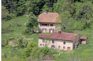
Vue de situation. Phot. Yves Sancey IVR43_19993900141ZA
