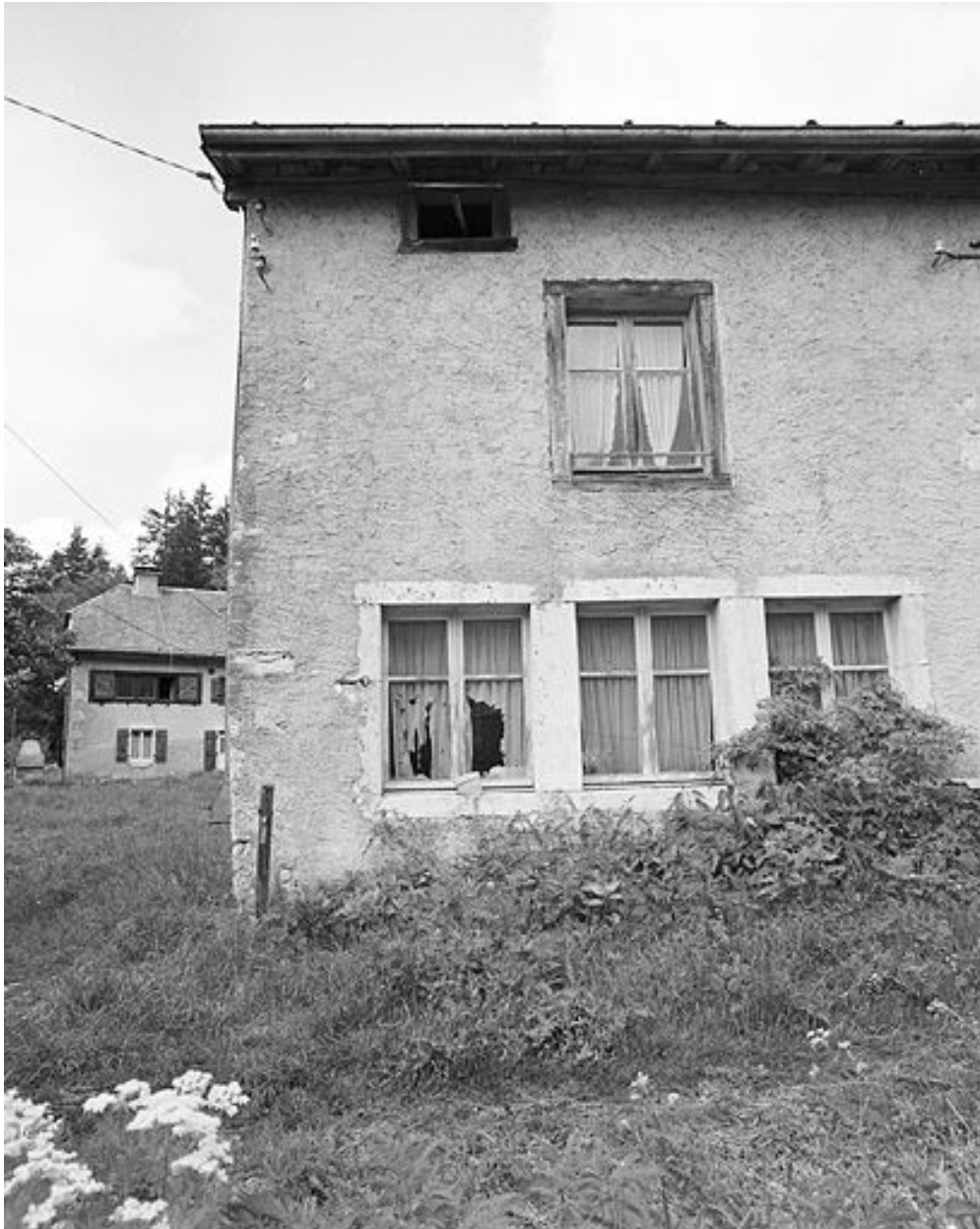
Les fenêtres de l'atelier.
