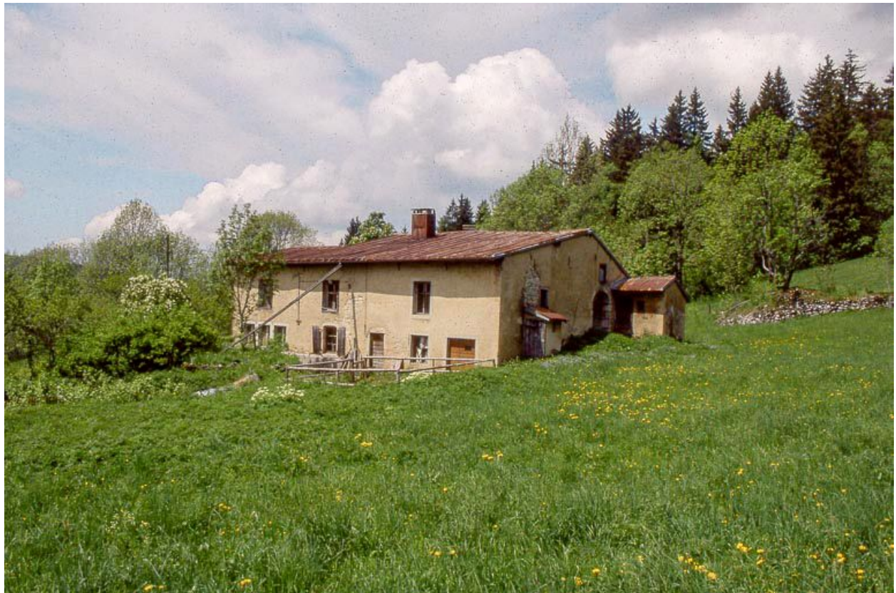
Vue éloignée de la façade antérieure.
