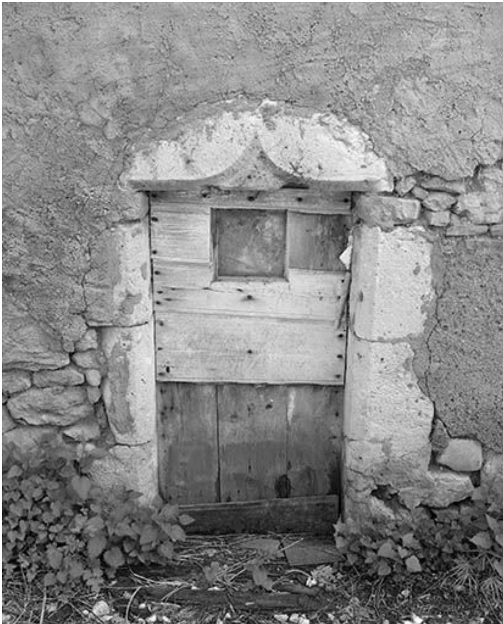
Linteau en accolade sur la façade postérieure.
