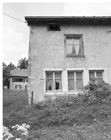
Les fenêtres de l'atelier. Phot. Yves Sancey IVR43_19993900159X
