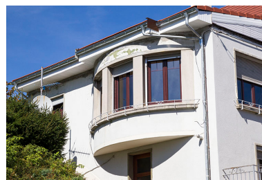
Façade latérale gauche : le bow-window. Phot. Yves Sancey IVR43_20132502319NUC2A
