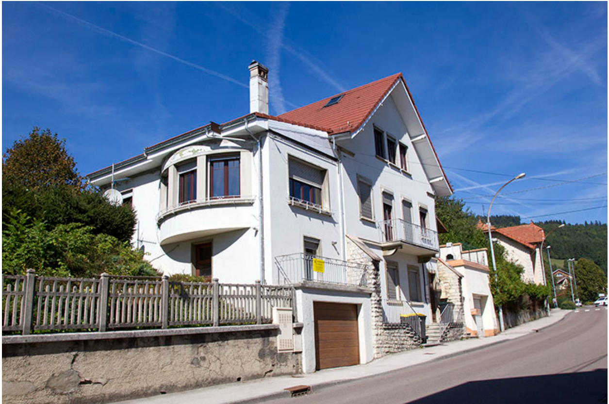
Façades antérieure et latérale gauche.
