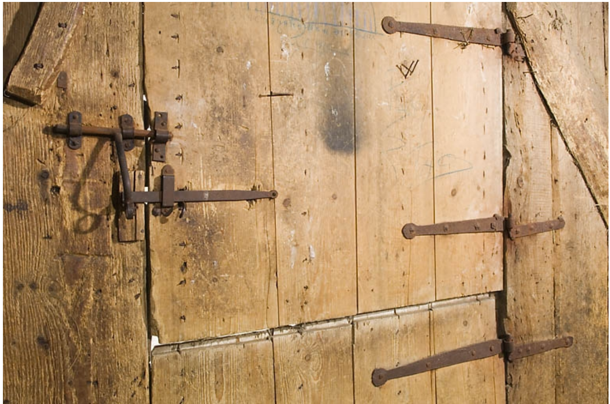
Façade antérieure, porte de grange : fermeture.
