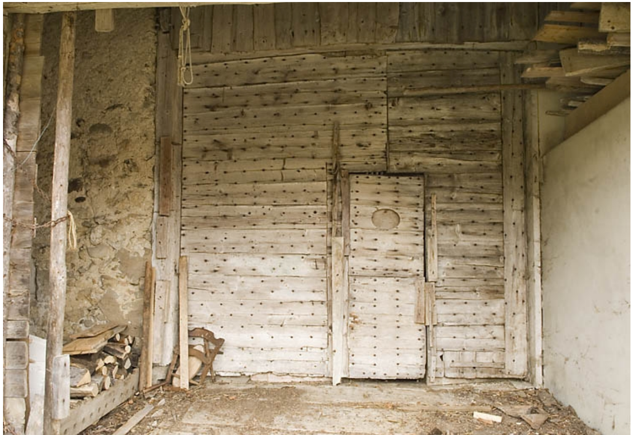
Façade postérieure : porte de la grange.
