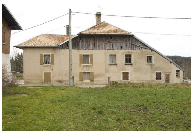
Façade latérale droite. Phot. Jérôme Mongreville IVR43_20082500836NUC2A
