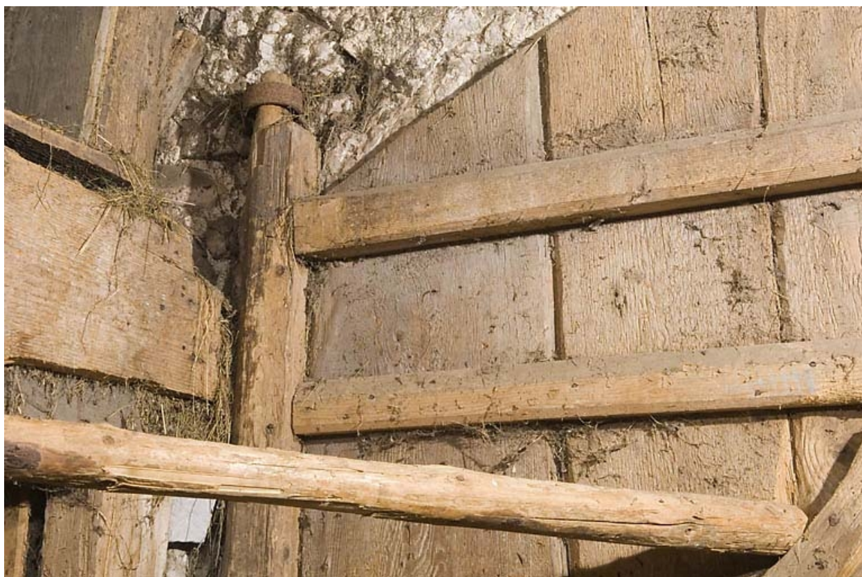
Façade antérieure, porte de grange : fixation de l'axe vertical du vantail de droite (collier en partie haute).
