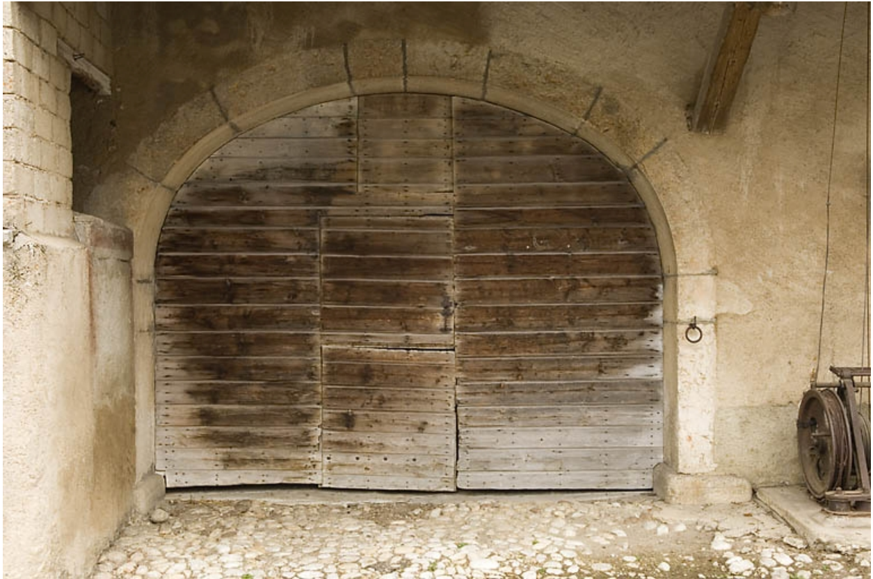
Façade antérieure : porte de la grange.
