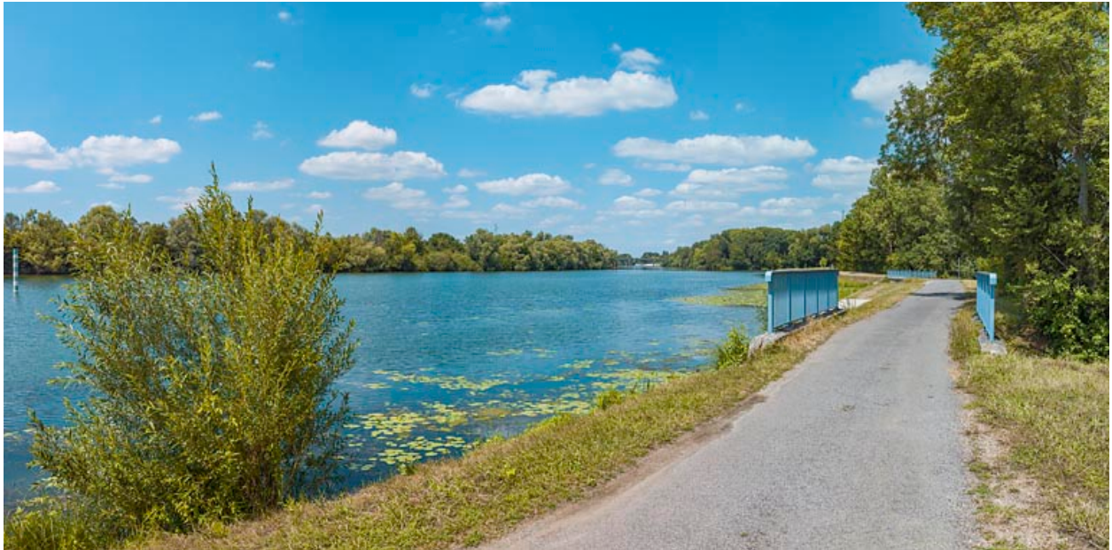
Vue d'ensemble des deux ponceaux, rive gauche.
