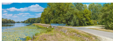
Ponceau sur la Roye. Phot. Thierry Kuntz IVR26_20192100166NUC4A
